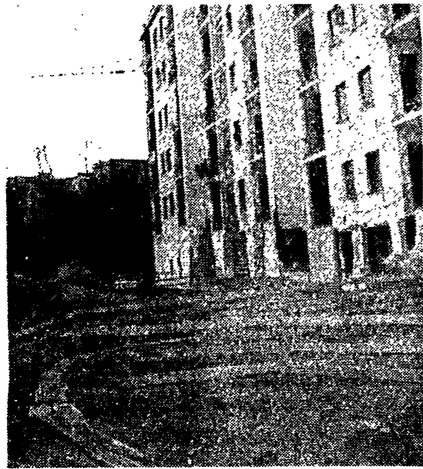
Casa popolare ISES del rione S. Anna, di recente franata. Come si vede sono in corso opere di consolidamento il cui costo si aggira sui 40 milioni, quasi il valore dell'intero fabbricato. Malgrado la frana, a fianco si sta costruendo un nuovo fabbricato
