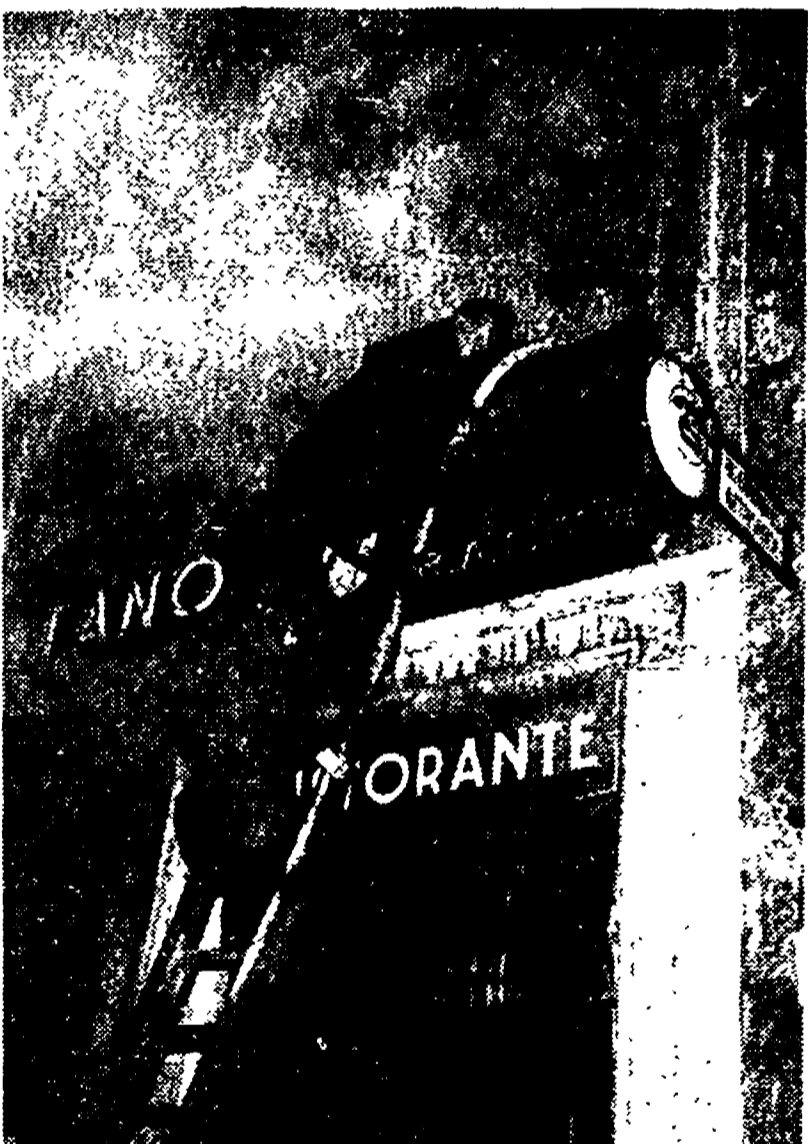
Un furioso incendio ha distrutto, in pochi minuti, a mezzanotte, il night-ristorante «Metropolitano», all'Esedra: due persone, il cuoco italo-americano e la moglie, sono morti, asfissati. Il rogo è stato provocato da un corto circuito. NELLA FOTO: i vigili tentano di raggiungere da una finestra l'interno del ristorante.
