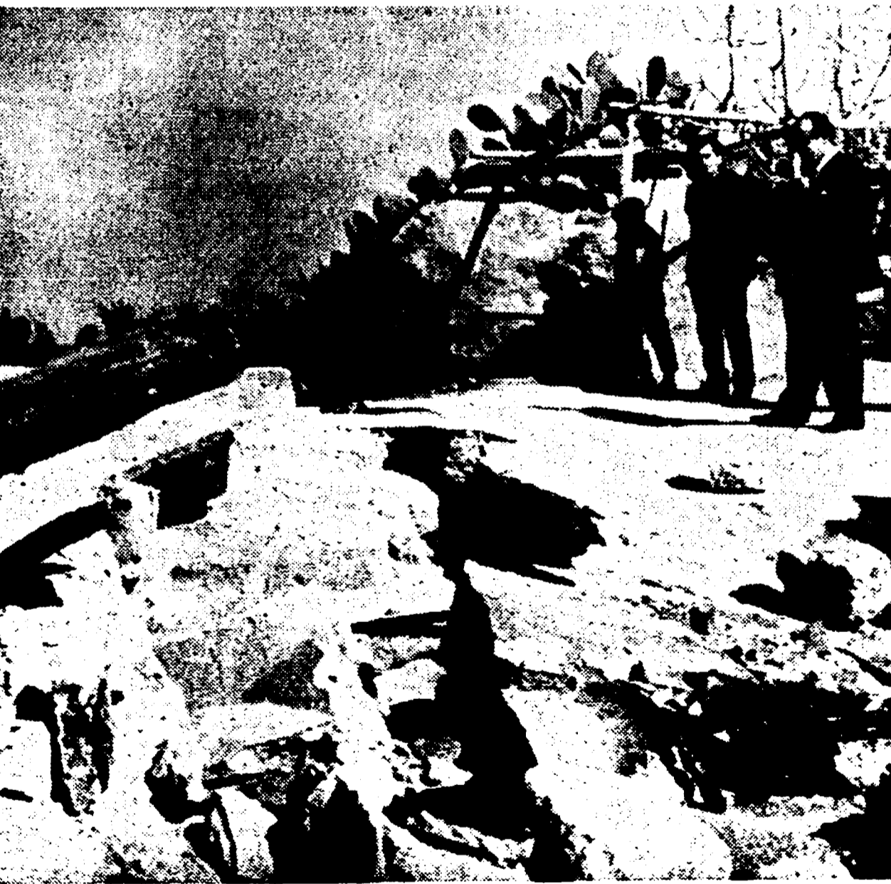
MARSALA — La strada colpita dal movimento franoso.
