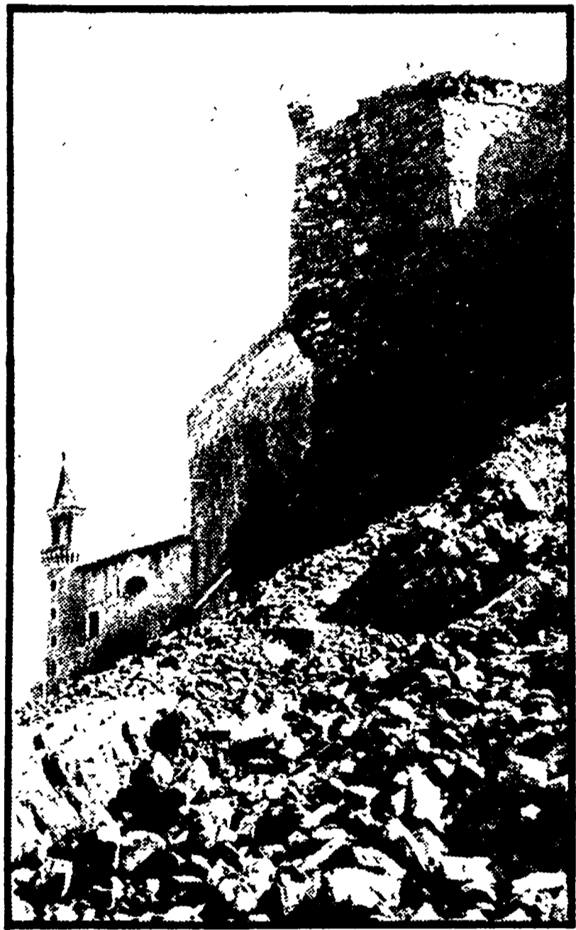
Il primo torrione delle antiche mura di Urbino, recentemente crollato
