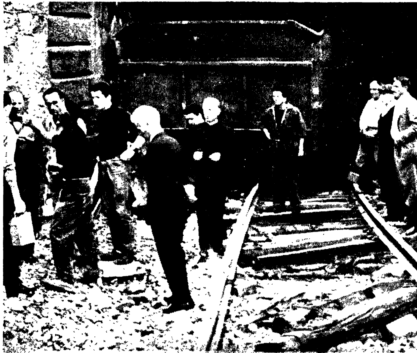
PISTOIA - Alcuni degli operai rimasti incolumi sul luogo dove è avvenuto l'incidente all'imbocco della galleria. Di traverso, sui binari, uno dei vagoni
