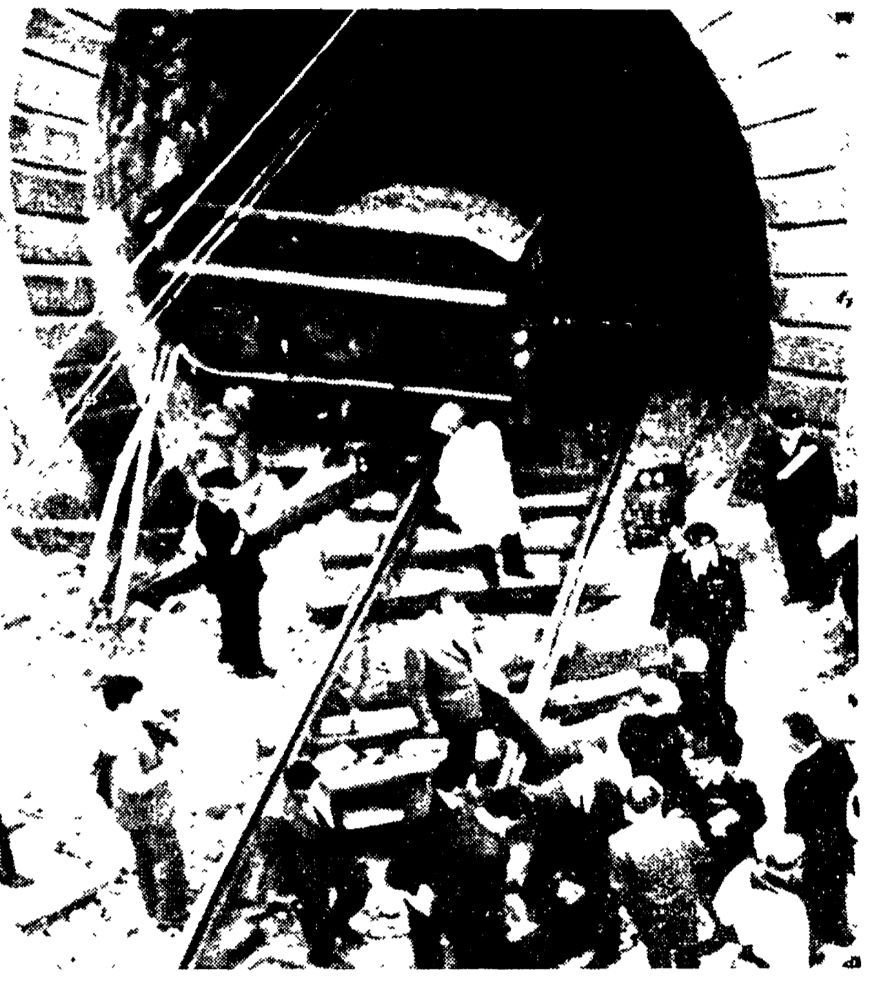
Gli operai lavorano per sgomberare la galleria del disastro
