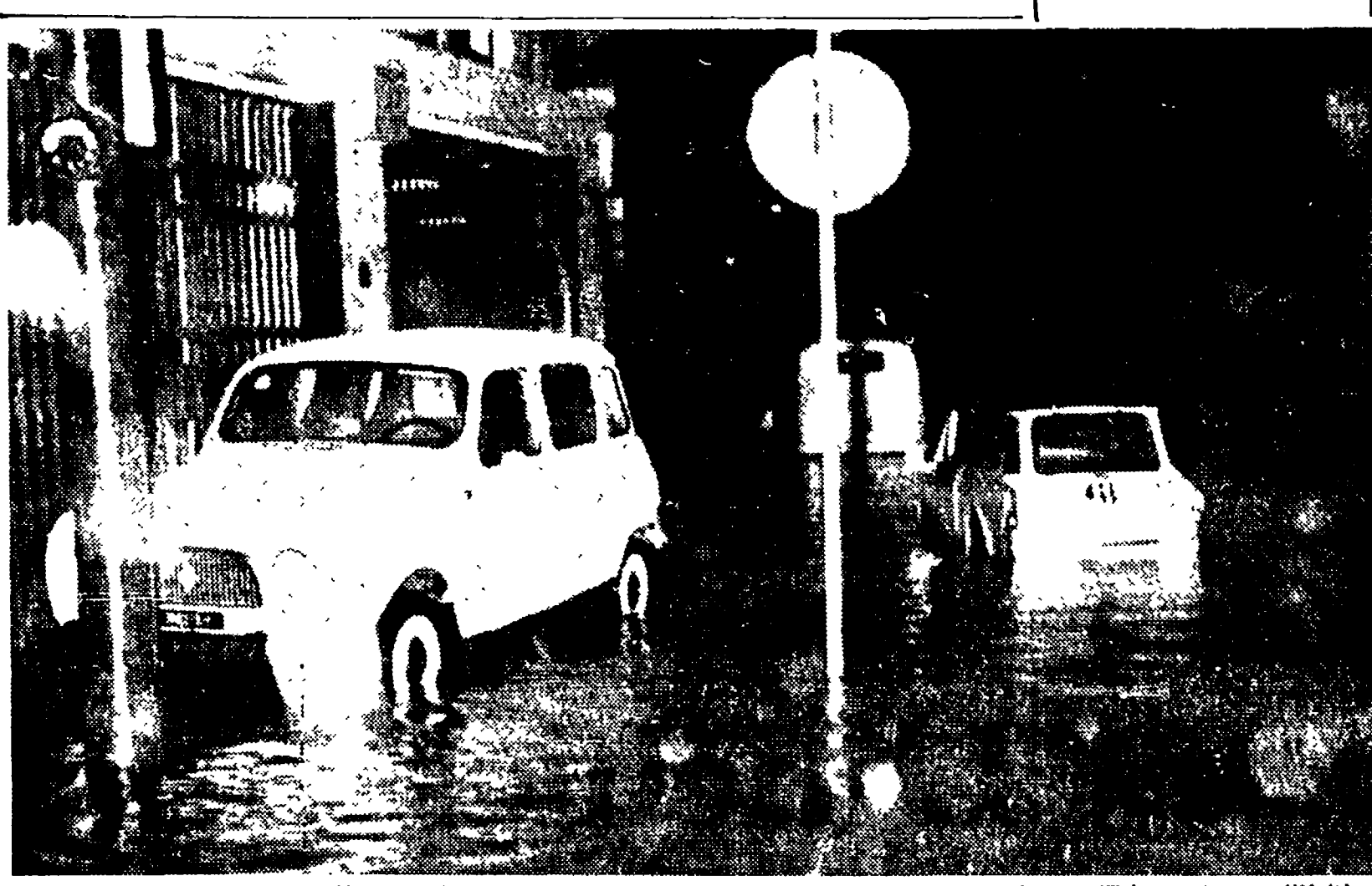
FIRENZE - Via delle Porte Nuove vicino al parco delle Cascine allagata da 15 centimetri d'acqua (Telefoto Ansa - «L'Unità»)
