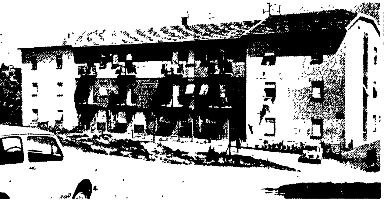
Ecco un edificio sito in rione Pinocchio sorto su un'area che il Piano regolatore vincolava a spazio pubblico. In particolare, nell'area era prevista la costruzione di un mercato rionale.
