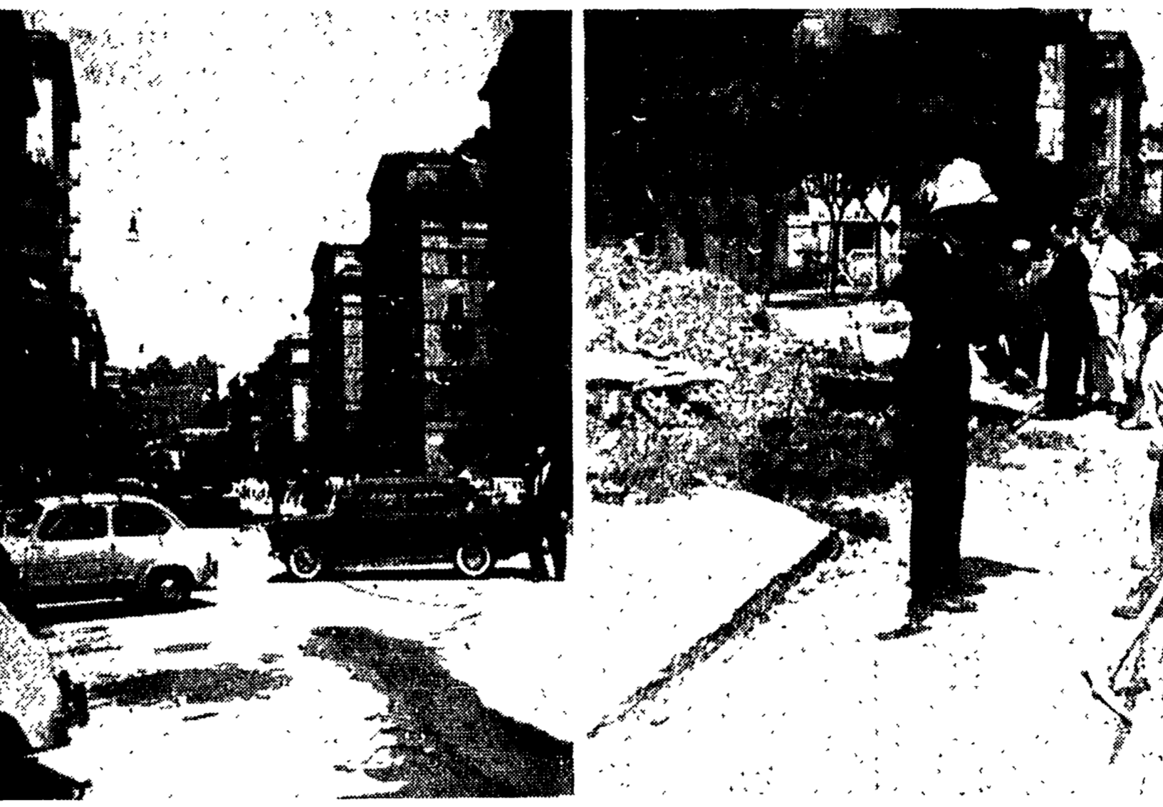
Via della Giuliana bloccata mentre sono in corso i lavori. Vigili urbani e tecnici dell'ACEA eseguono i primi rilievi.
