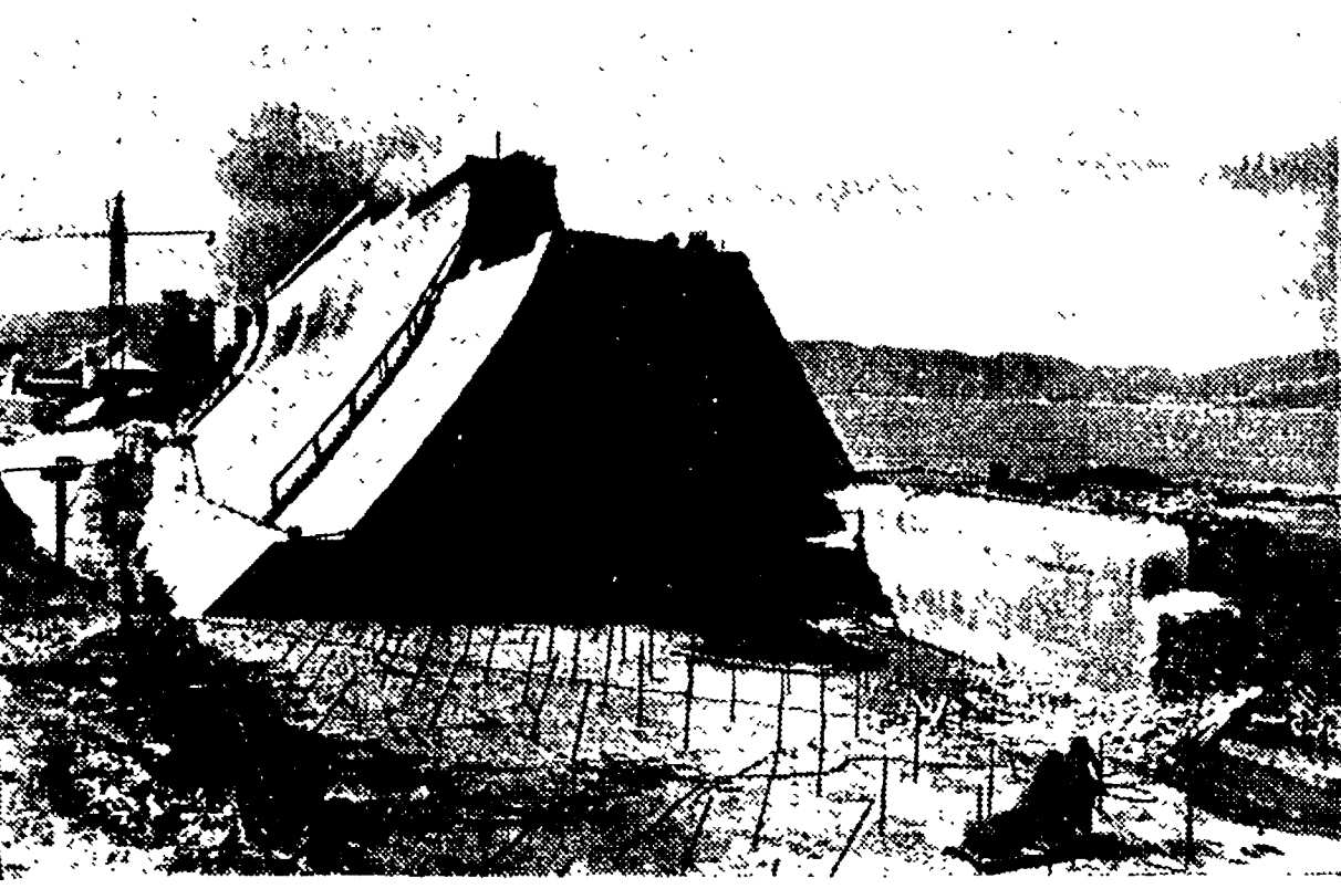
I lavori di sopraelevazione della diga di Campotosto
