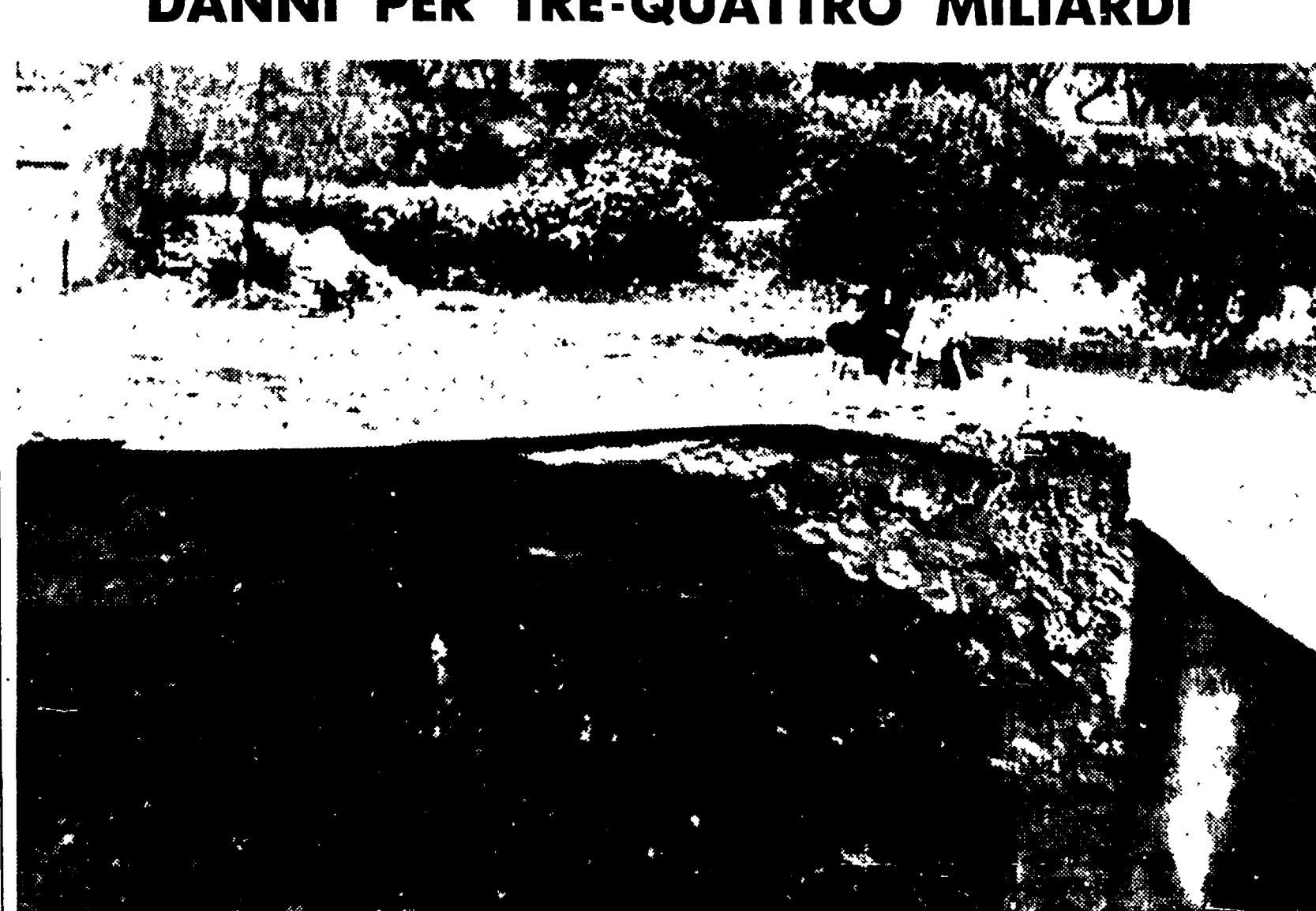
SASSARI - La strada statale n. 200 che conduce a Castelsardo interrotta a causa di un'ampia voragine (Telefoto)
