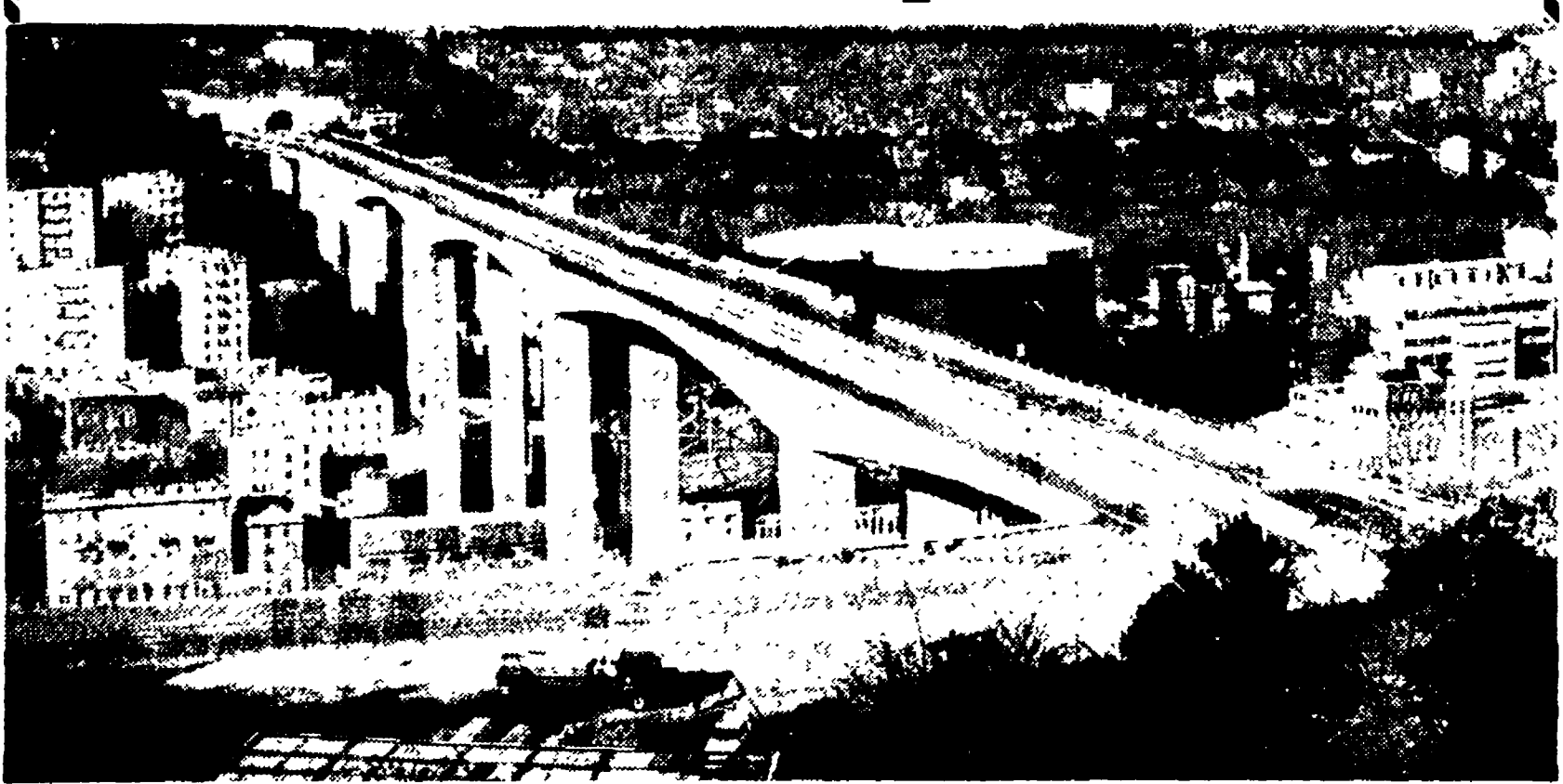
GENOVA - Da oggi si può andare in auto da Milano alla Riviera ligure di ponente risparmiando una buona mezz'ora. Nel pomeriggio, infatti, presenti l'en. Moro e il ministro alle Partecipazioni statali Bo, sarà inaugurato il tratto autostradale Rivarolo-Nervi, che consentirà di «saltare» la città di Genova. Si tratta di dodici chilometri che collegano la Serravalle-Genova all'autostrada azzurra, per ora in esercizio soltanto, che si snocciola nel nuovo bosco (nella foto il viadotto sul Bisogno) corso per il 20 per cento su viadotto, e solo per il 30 per cento su semplice scavo. La cerimonia dell'inaugurazione avrà inizio alle ore 15 di oggi.
