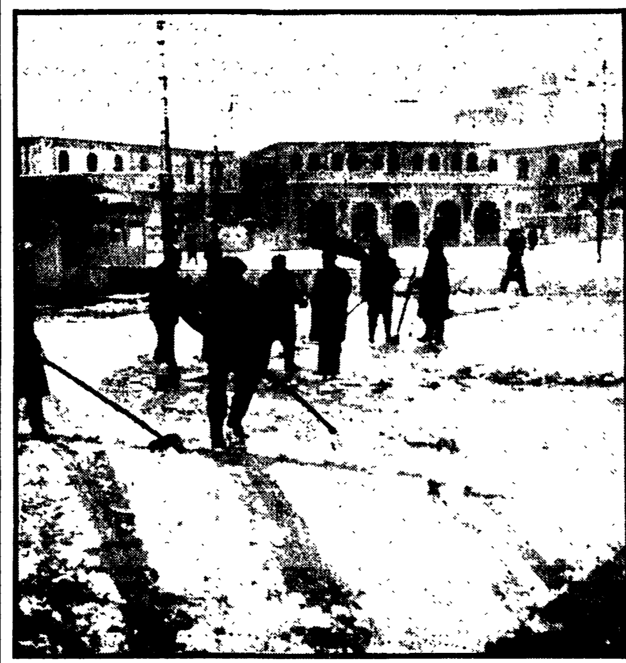
Spalatori al lavoro sul piazzale antistante la stazione di Porta Susa a Torino.
