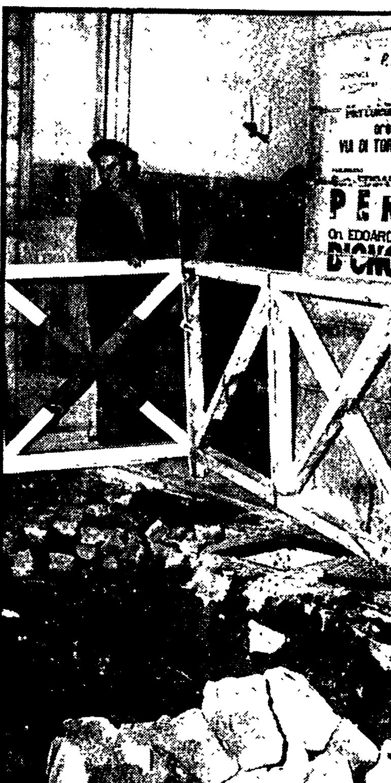
Voragine in via Casilina. Per la rottura di un tubo dell'acqua, una grossa buca si è spalancata ieri pomeriggio davanti ai numeri 361 e 363 della strada.
