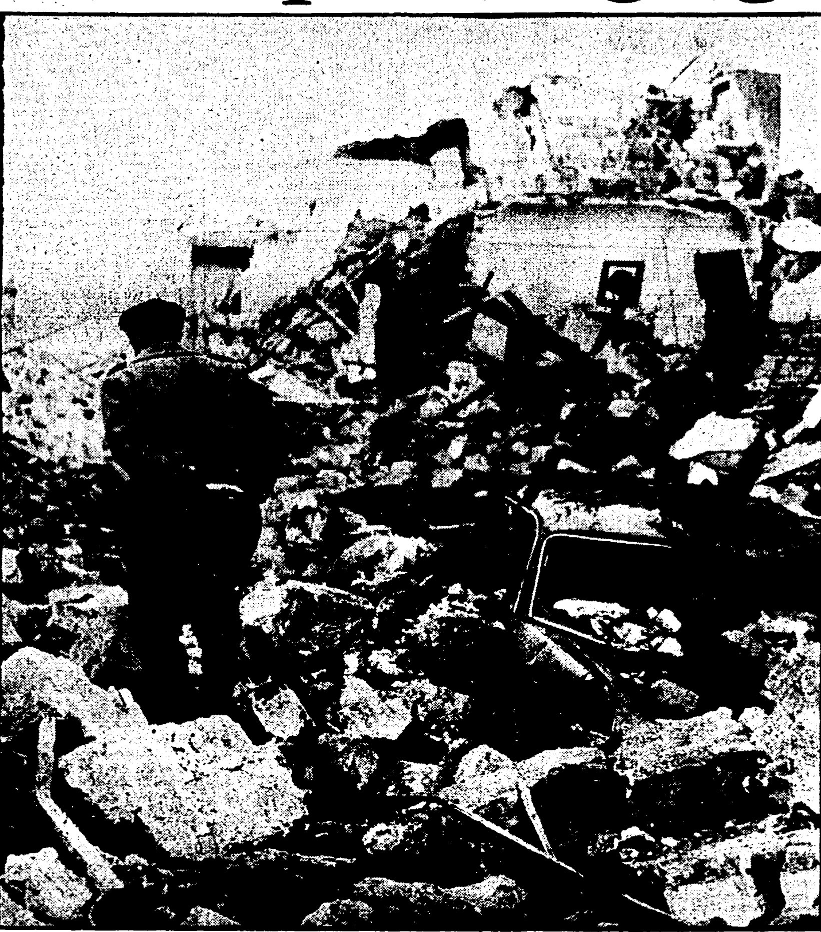
MONTEVAGO - Il rapporto ministeriale dice laconico: « Montevago, provincia di Agrigento. Totalmente distrutto. Tutte le case, comprese le chiese, il municipio, le scuole, sono crollate. Tutti gli impianti igienici, le strade, l'elettricità dovranno essere di nuovo costruiti. Almeno 200 i morti, 150 mila i metri cubi di macerie da asportare. Solo da poche ore i primi soccorritori sono arrivati a misurare tanta desolazione: sono due continue di macerie, più alle della statura umana. (Tel. Pais-Sartarelli)
