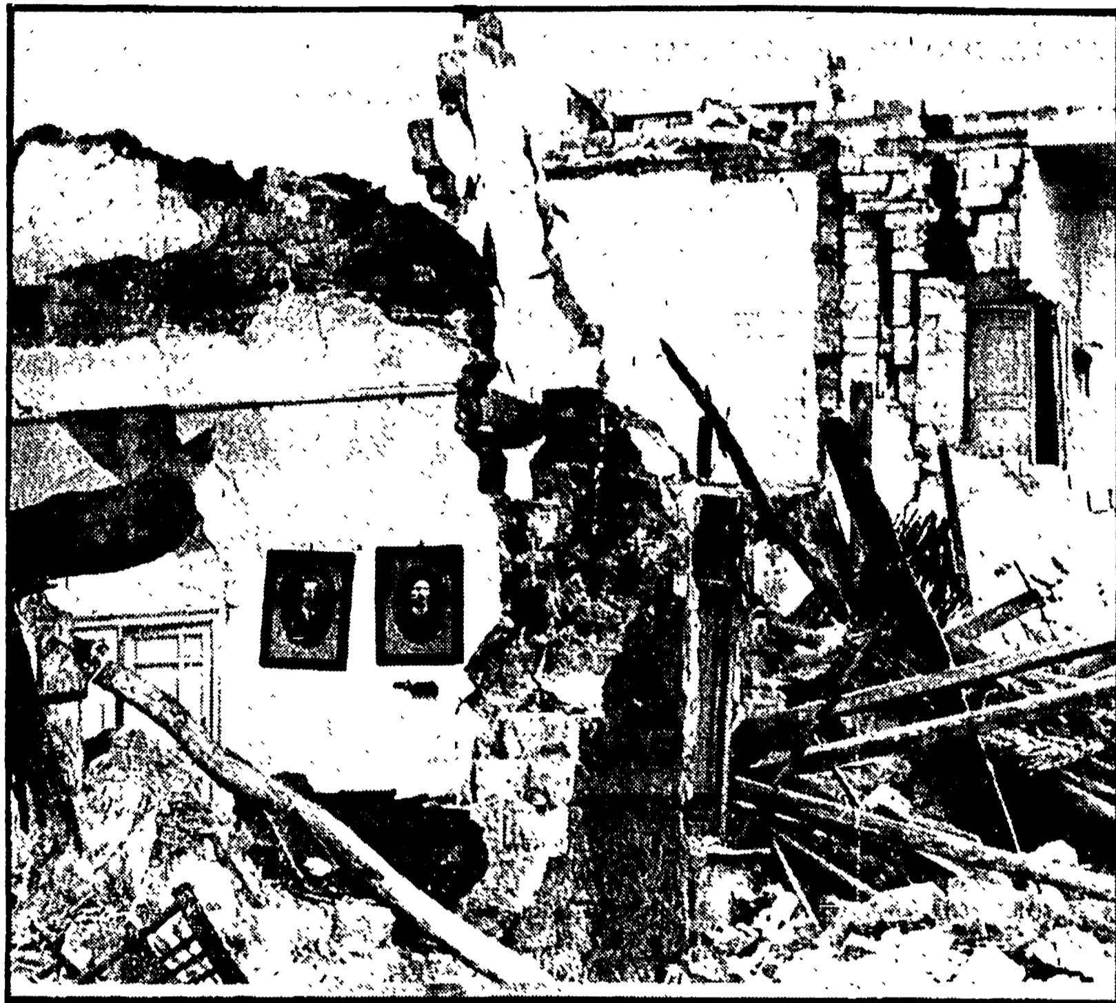
Due ritratti di famiglia rappresentano le uniche cose salvatesi nel crollo di una casa andata completamente distrutta. (Telefoto Pais-Sartarelli)
