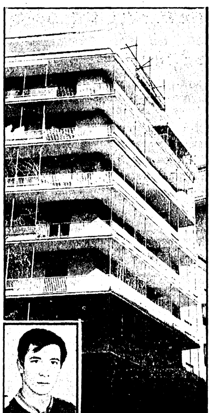
Il palazzo di via dei Tadolini dove, ieri mattina, è avvenuta l'ennesima sciagura sul lavoro. L'edile Giuseppe Gioeca (nel riquadrato) di appena vent'anni è morto precipitando dal nono piano. Era in bilico su una scala per riverniciare un muro esterno della terrazza; con un urlo straziante è piombato di sotto da venticinque metri.
