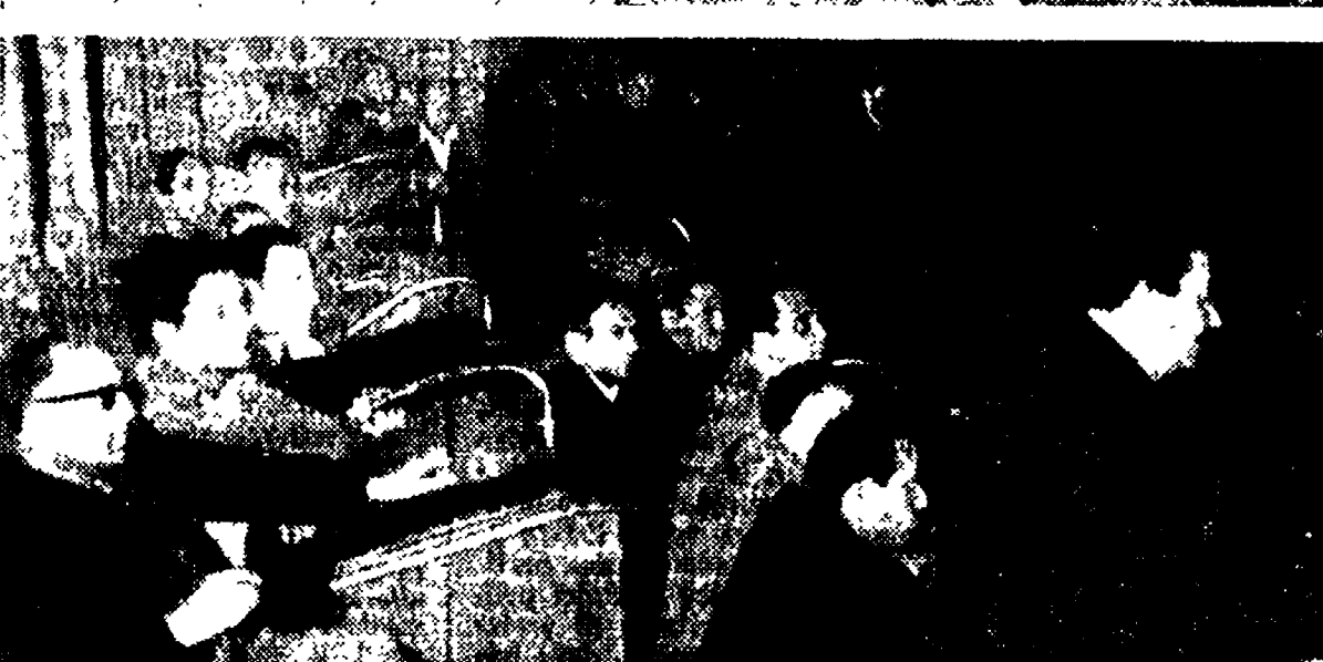
Foto in alto: la voragine in via Pisa. Sopra: l'assemblea dei sinistrati indetta dalla Giunta
