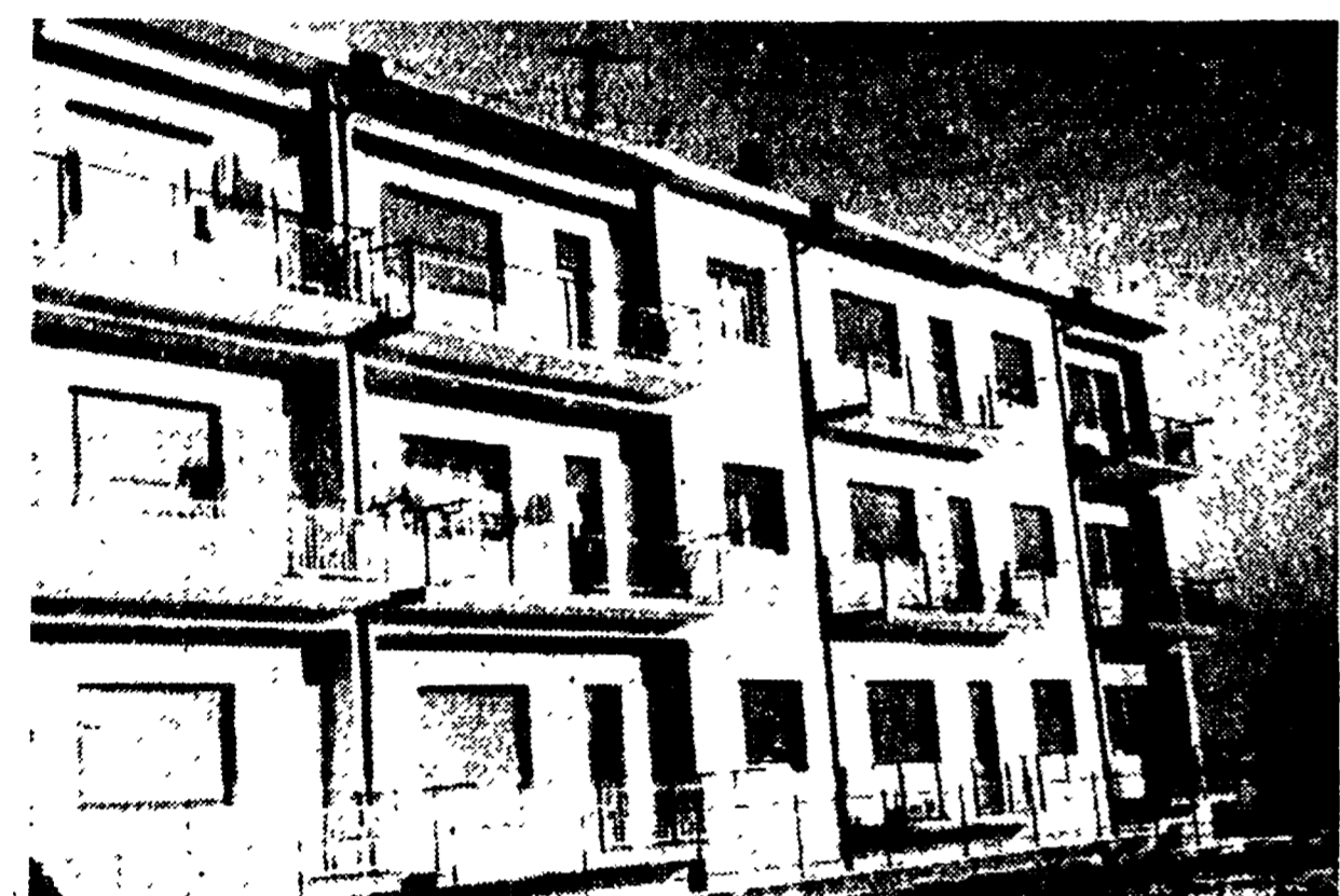
Questo fabbricato, secondo i tecnici, deve essere demolito perché le strutture portanti non corrispondono alle norme tecniche
