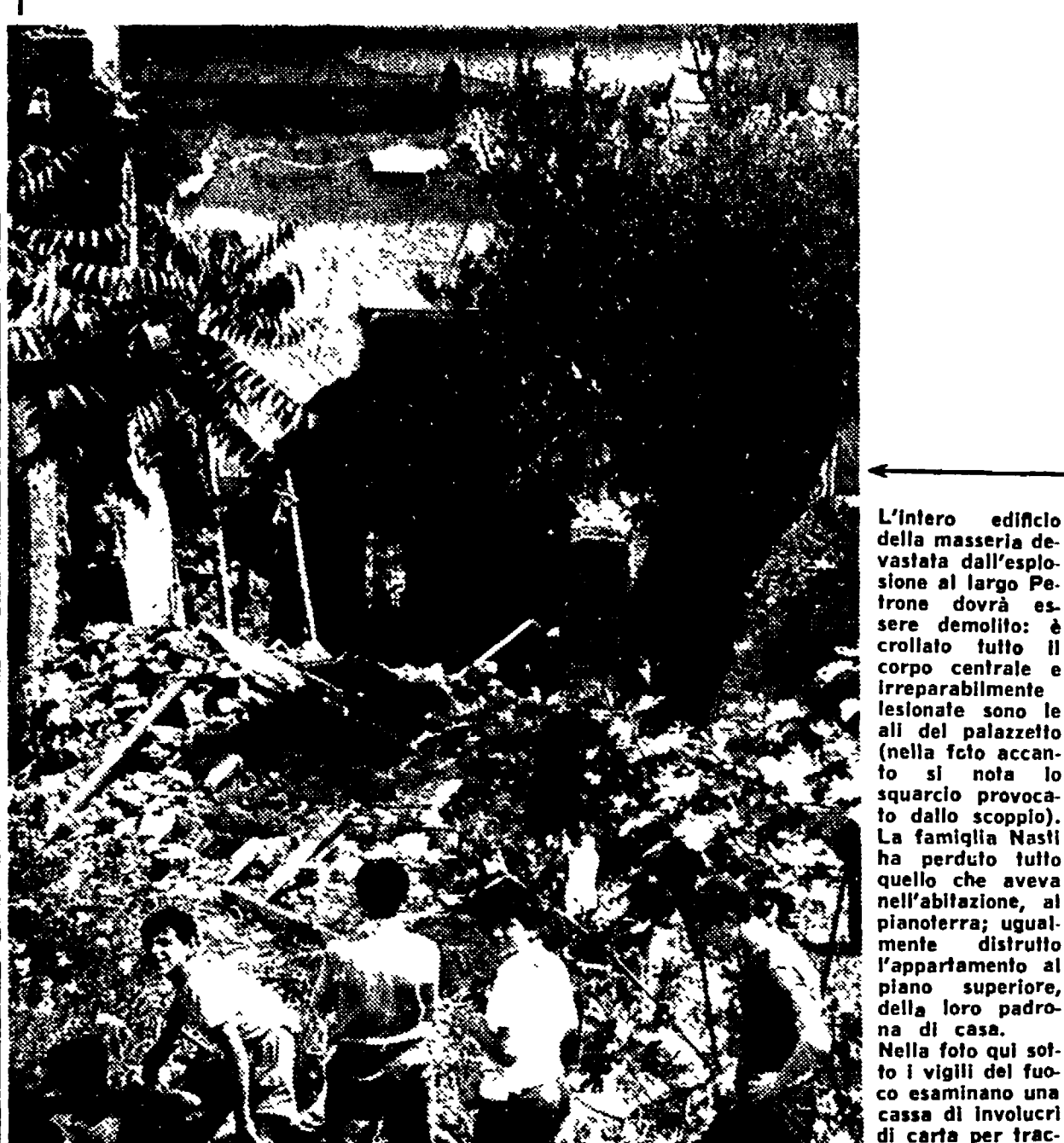
L'intero edificio della masseria devastata dall'esplosione al largo Petrone dovrà essere demolito: è crollato tutto il corpo centrale e irreparabilmente lesionale sono le ali del palazzo (nella foto accanto) si nota lo squarcio provocato dallo scoppio).
