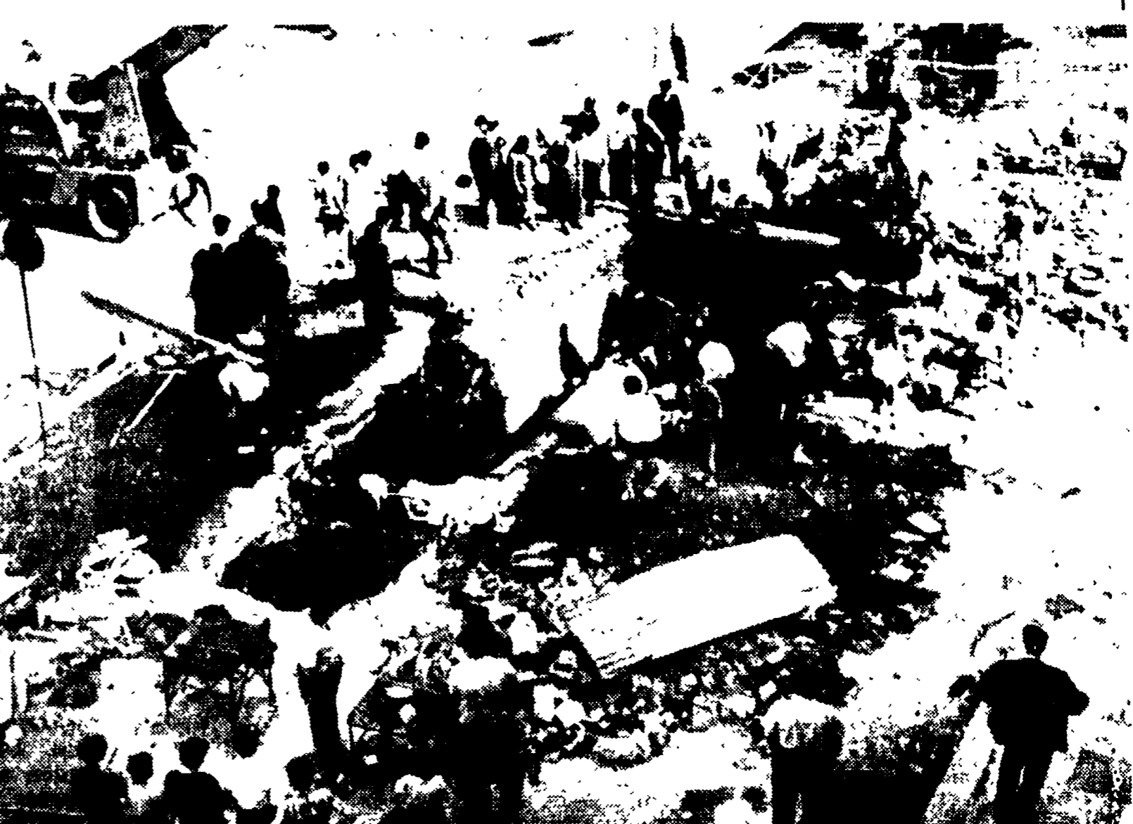
Un'ampia voragine anche al corso Novara: ancora una volta la strada è stata squarciata dalla rottura delle condutture dell'acquedotto che ha provocato la fuoriuscita di una colonna di acqua alto 12 metri. La sede stradale, ieri, è stata spaccata in diversi punti. Il cedimento di maggiori proporzioni si è avuto all'angolo tra il corso Novara, via Venezia e via Ferrara. Sono rimasti danneggiati notevolmente anche il corso Meridionale, via Genova e via Palermo. Ovviamente il traffico è interrotto e non potrà essere riavuto. Per fortuna non si lamentano feriti; nel momento in cui si è avuta l'esplosione della tubatura sulla strada non c'era nessuno. Erano le 7,50 del giorno di festa e pochissime auto si trovavano a passare nella zona.
