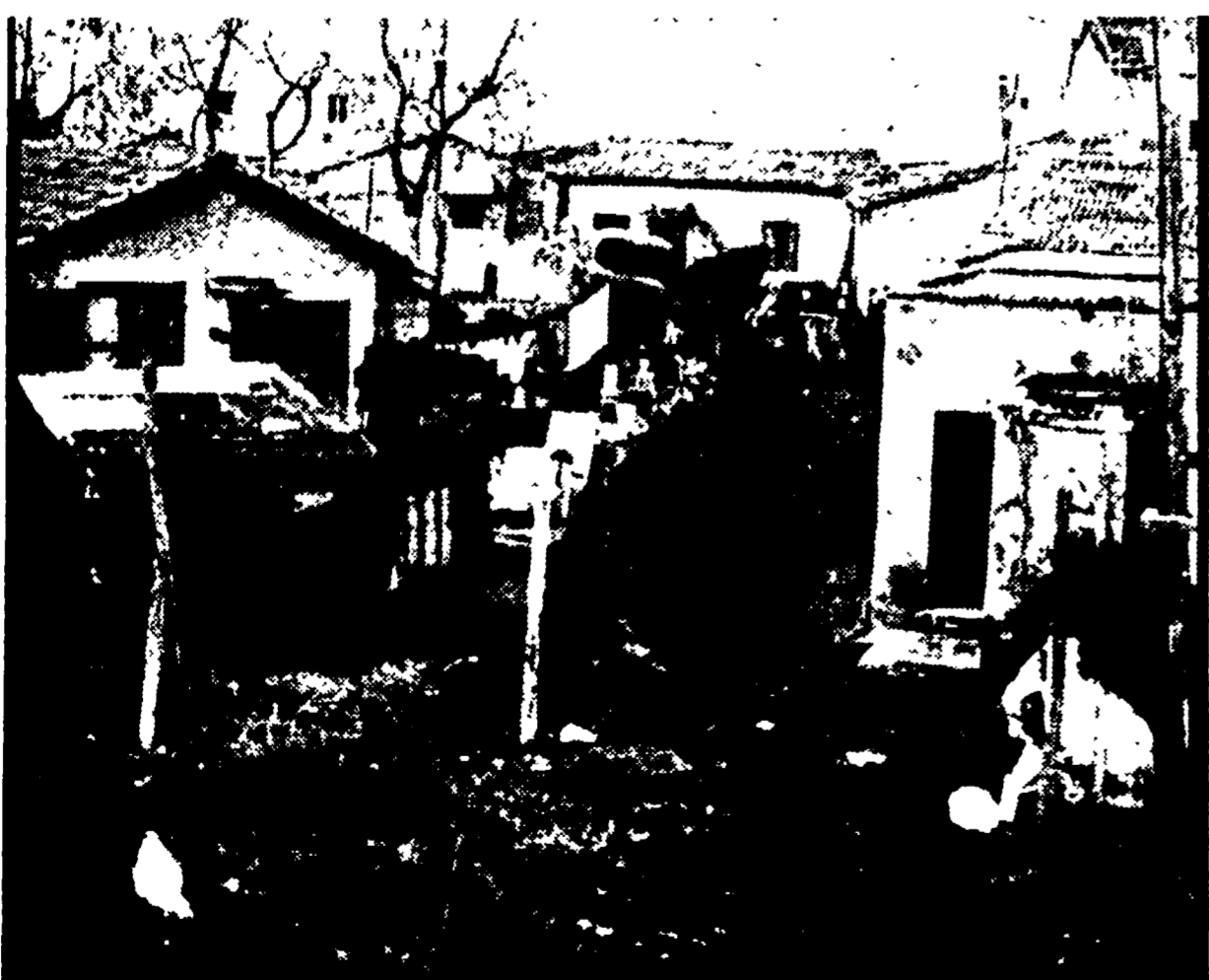
Un aspetto delle baracche di via Aristeo
