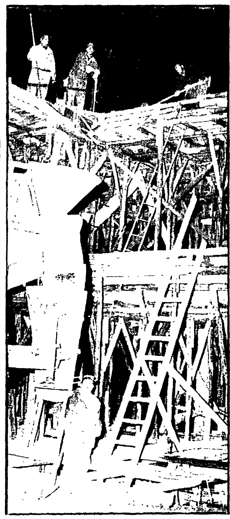
La costruzione della villetta abusiva nei pressi delle Fosse Ardeatine prosegue di notte (come si vede nella foto) al lume dei riflettori
