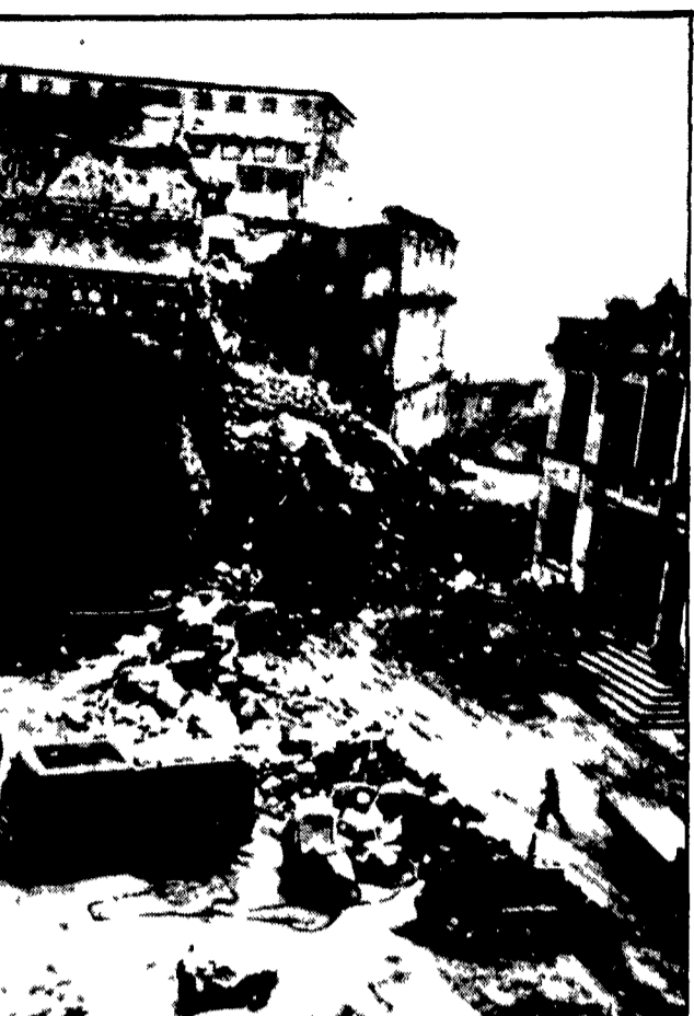
Il disastro di Catanzaro. A Catanzaro, dopo il tragico crollo del muraglione del vecchio carcere « San Giovanni » che è costato la vita ad una famiglia di quattro persone (marito, moglie e due figli in tenera età), prosegue l'opera di rimozione delle macerie. Purtroppo non si esclude che il crollo al castello aragonese (riadattato a galera nel 1823 e già pericolante nel 1939) abbia provocato anche altre vittime.
