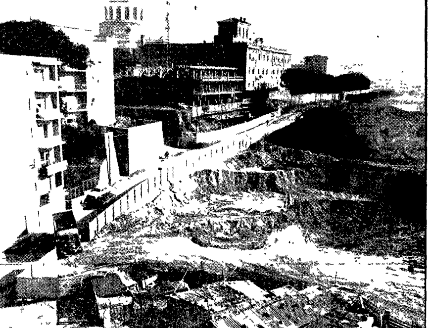
Ecco il terreno in contestazione fra il Comune e la società «Roma al mare». La foto è stata scattata un anno fa, quando le ruspe stavano preparando il terreno dove dovevano sorgere le costruzioni autorizzate dal Comune. Così il Campidoglio si trovò in una situazione paradossale: aveva concesso la licenza di costruzione su un terreno che rineviava di sua proprietà. Oggi su quest'area sono già sorte numerosi palazzi che la «Roma al mare» ha già posto in vendita, anche se la questione della proprietà del terreno non è stata ancora definita.
