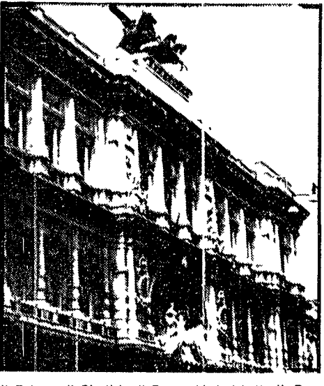
Il Palazzo di Giustizia di Roma chiude i battenti. Dopo i recenti crolli di blocchi di travertino, il provvedimento alle opere pubbliche ha infatti dichiarato l'inagibilità di tutti i locali. A PAGINA 5
