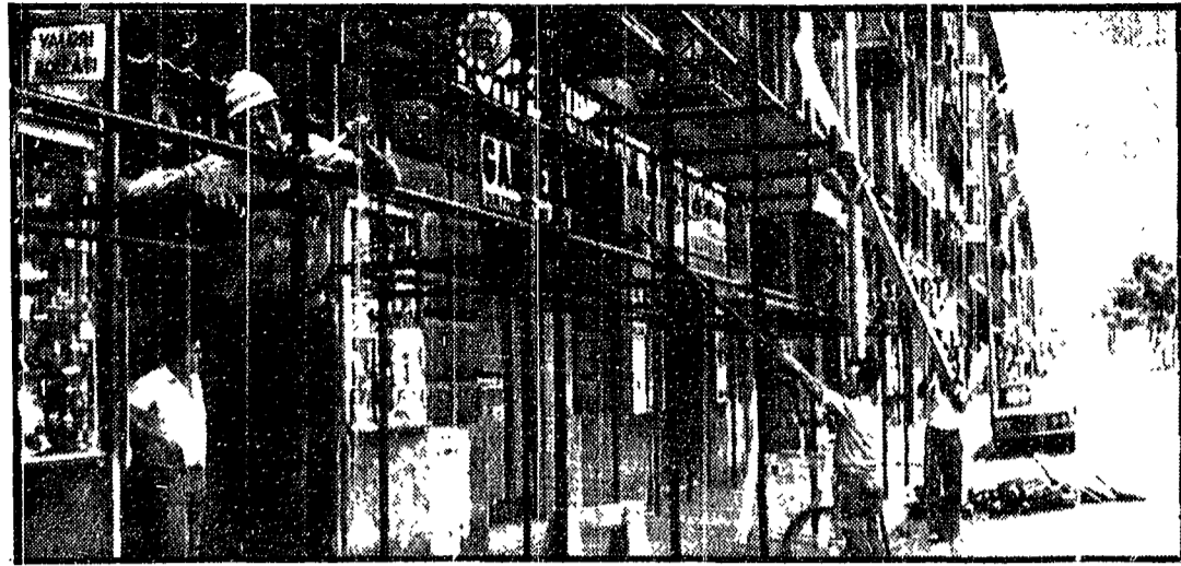
Operai puntellano i palazzi di via Appia lesionati
