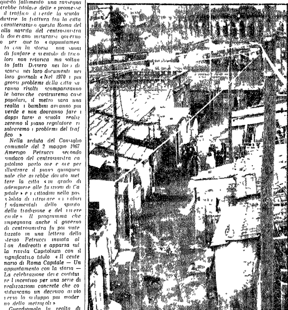
DOVA ESSERE la grande realizzazione del cantiere la eliminazione delle baracche. Comune e governo di centrosinistra - che si era erose le promesse - avevano studiato un piano avulso dalla situazione nazionale (il senaletto non sono soltanto a Roma), che avrebbe dovuto risolvere per il '70 il grave problema. Incontrati discorsi parole. E intanto la «167» rimaneva bloccata. Il sindaco attuale, Daria da rante l'ultima campagna elettorale si recò nel borghetto Prenestino, ancora per promettere. Dire che fu contestato, è poco.
