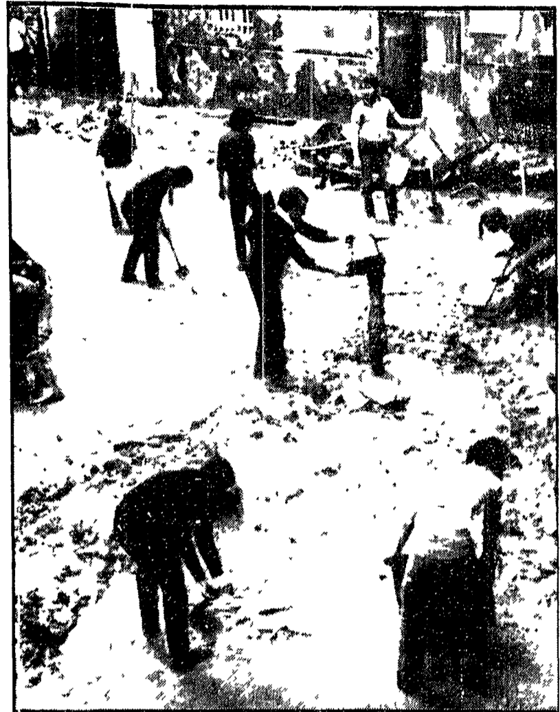
GENOVA - La città sconvolta cerca, con la forza dei suoi giovani, dei lavoratori, delle organizzazioni popolari di riparare ai danni ingenti dell'alluvione che ammonfano, in tutta la provincia, a circa 500 miliardi. All'angoscia delle popolazioni, aggravata dal maltempo che torna ad incomberne, si è aggiunta l'esasperazione e l'amarezza per il decreto governativo, che annuncia misure del tutto insufficienti, incapaci di sanare anche le ferite più gravi. Nella foto: gruppi di giovani al lavoro nelle strade ancora invase dal fango. A PAGINA 8
