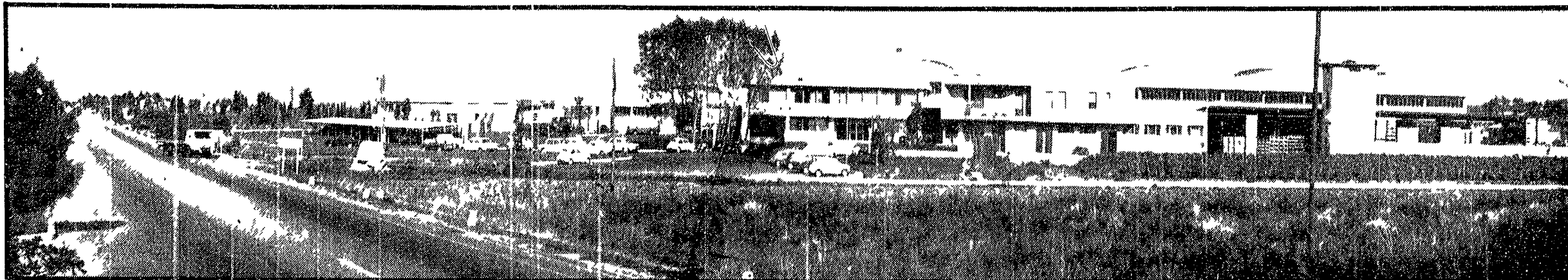
Una veduta della nuova sede secondaria del Coop Italia di Riolorto (Piombino). Essa occupa un'area di circa 50.000 metri quadrati di cui 10.000 coperti. Comprende i diversi reparti di lavorazione alimentare, extra alimentare, centro elettronico per l'elaborazione dei dati, reparti latticini, salumi e orofruita, servizi per il personale, pronto soccorso, alloggio custode e, in costruzione, il reparto carni. A Riolorto avrà sede anche la direzione della nuova Cooperativa che sorgerà dall'unificazione della «Proletaria» e della «Fratellanza».
