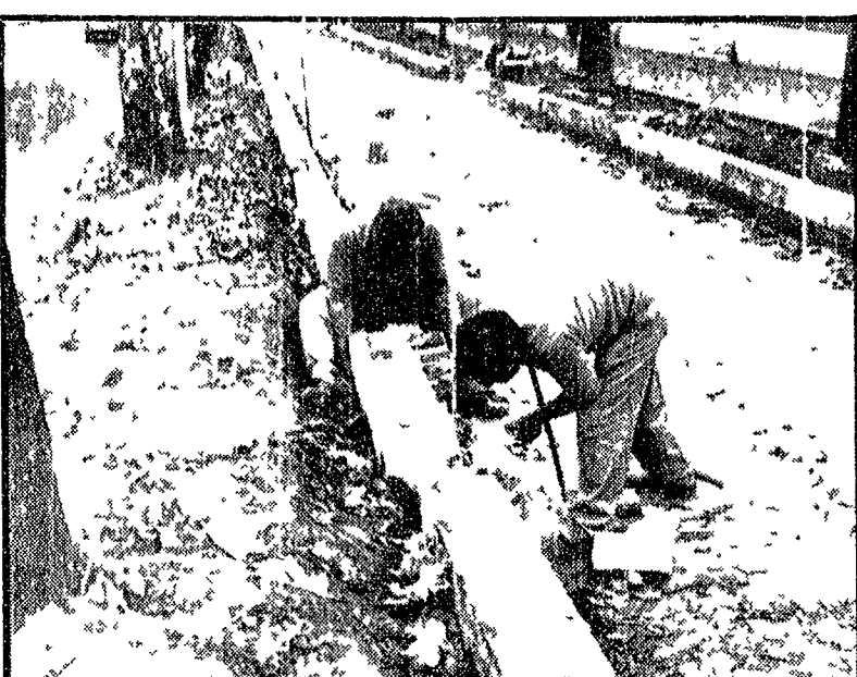
I lavori per la costruzione delle strade laterali di via Nomentana
