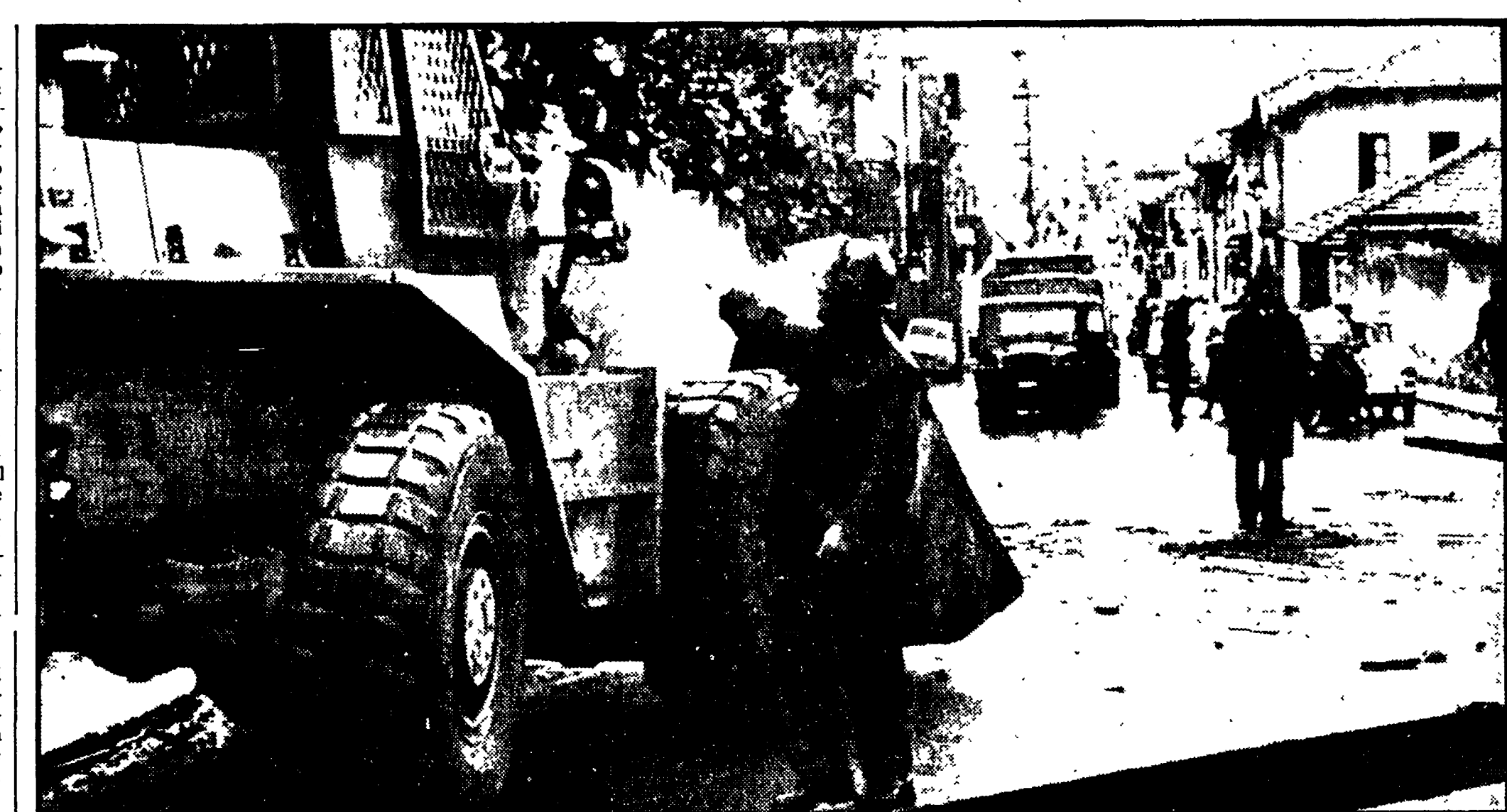
REGGIO CALABRIA — Un bulldozer in azione nel rione Santa Caterina per rimuovere le ostruzioni stradali
