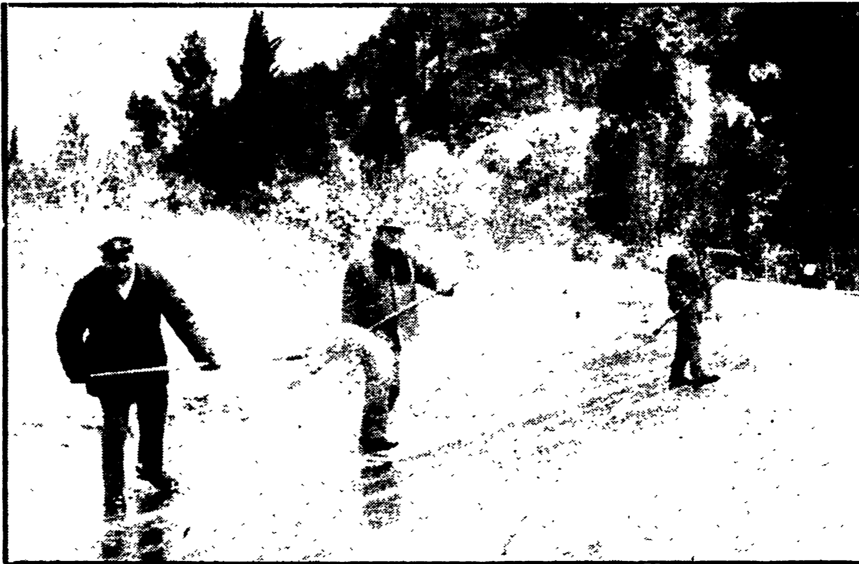
Operai dell'ANAS cospargono di sabbia un tratto della Flaminia, dove è ghiacciato
