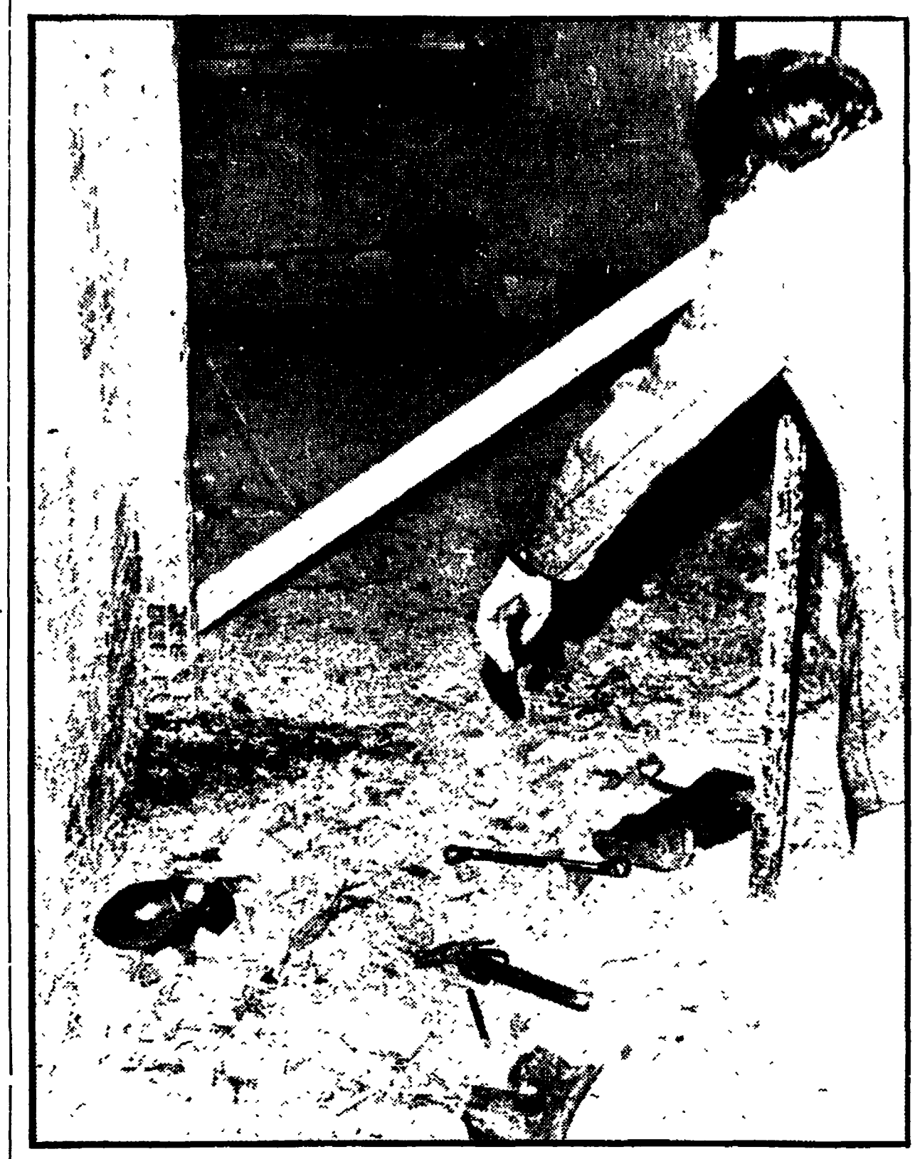
Qui si è schiantato l'edile Domenico Cervoni. Era un «pontista». Si notano al suolo i ferri del mestiere. Nella foto del titolo: il punto dove è precipitato l'operaio. Secondo la polizia e le testimonianze di alcuni operai, le tavole di recinzione sono state collocate dopo la caduta
