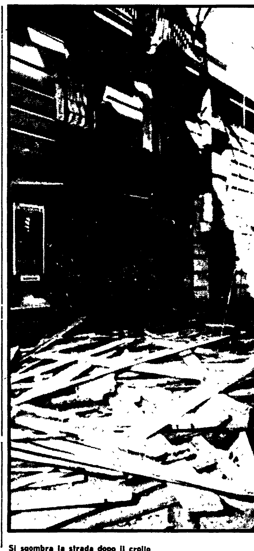
Si sgombra la strada dopo il crollo
