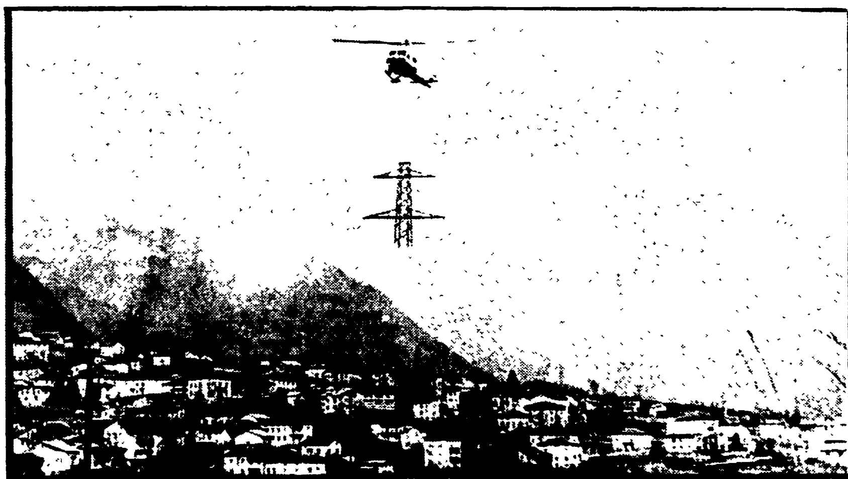
L'elicottero va assumendo, in ogni settore industriale, una sempre più grande importanza. L'ENEL ha provveduto, dal canto suo, alla sperimentazione del mezzo aereo in svariati lavori di elettrificazione. I risultati maggiormente significativi sono rappresentati dalla notevole economicità del lavoro riferita soprattutto ai tempi di montaggio di tralicci o pali per linee elettriche.
