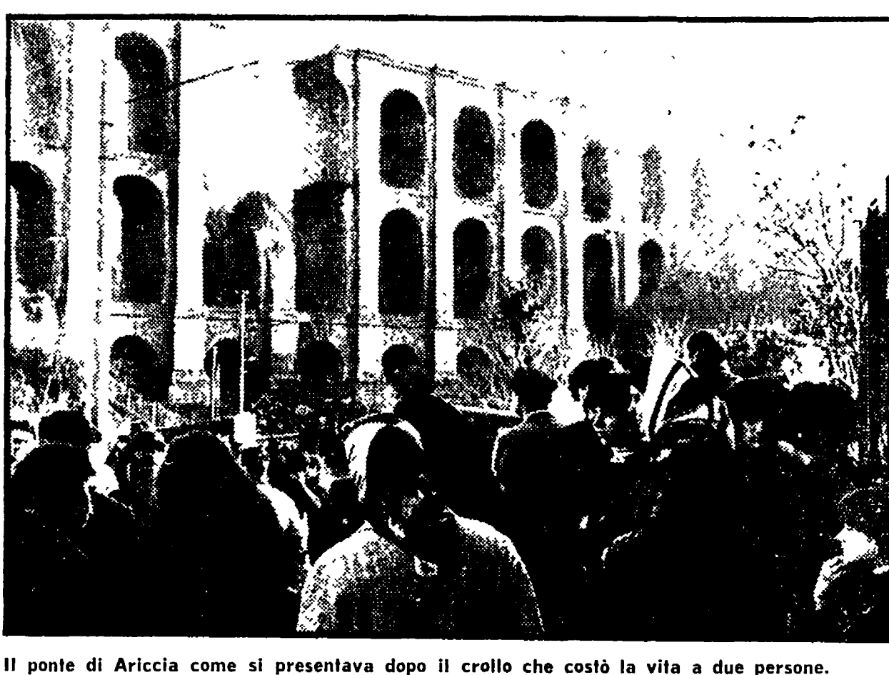
Il ponte di Ariccia come si presentava dopo il crollo che costò la vita a due persone.
