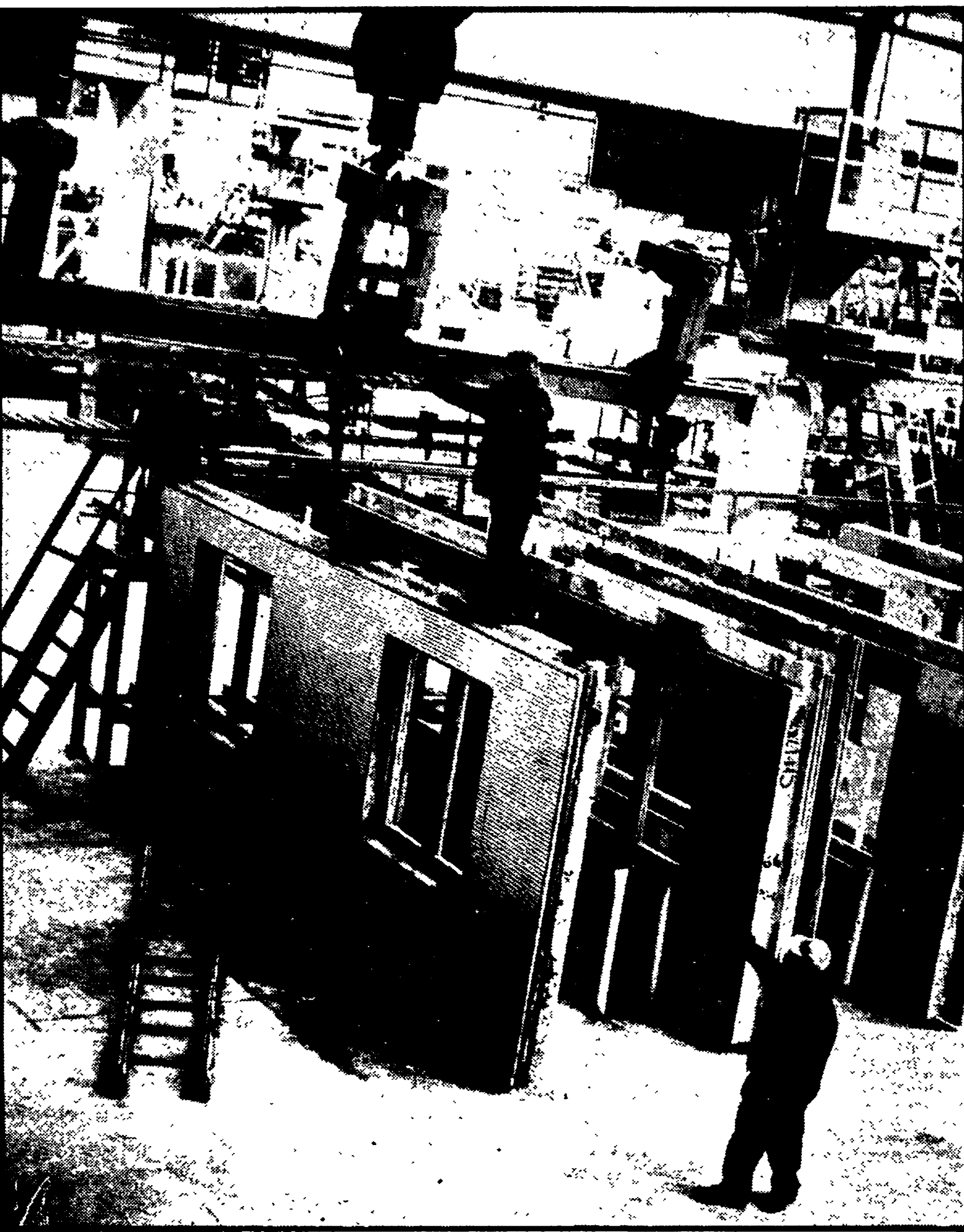
Un reparto della fabbrica di Riga, in Lettonia, che produce gli elementi per le case d'abitazione prefabbricate.
