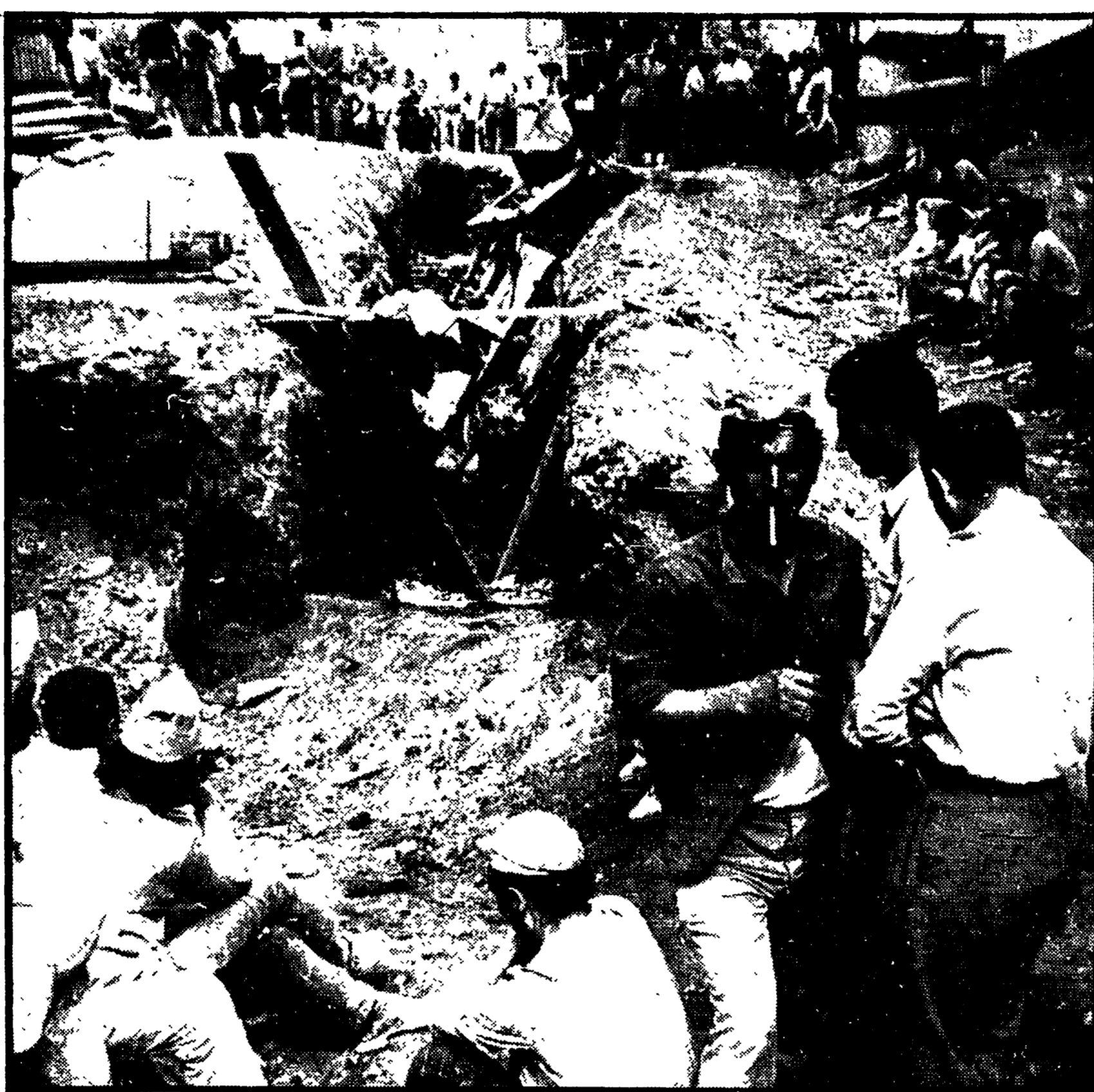
Il cantiere dove ha trovato la morte l'edile Giuseppe Santolamazza. Il corpo è ancora sotto la ruspa che stava manovrando
