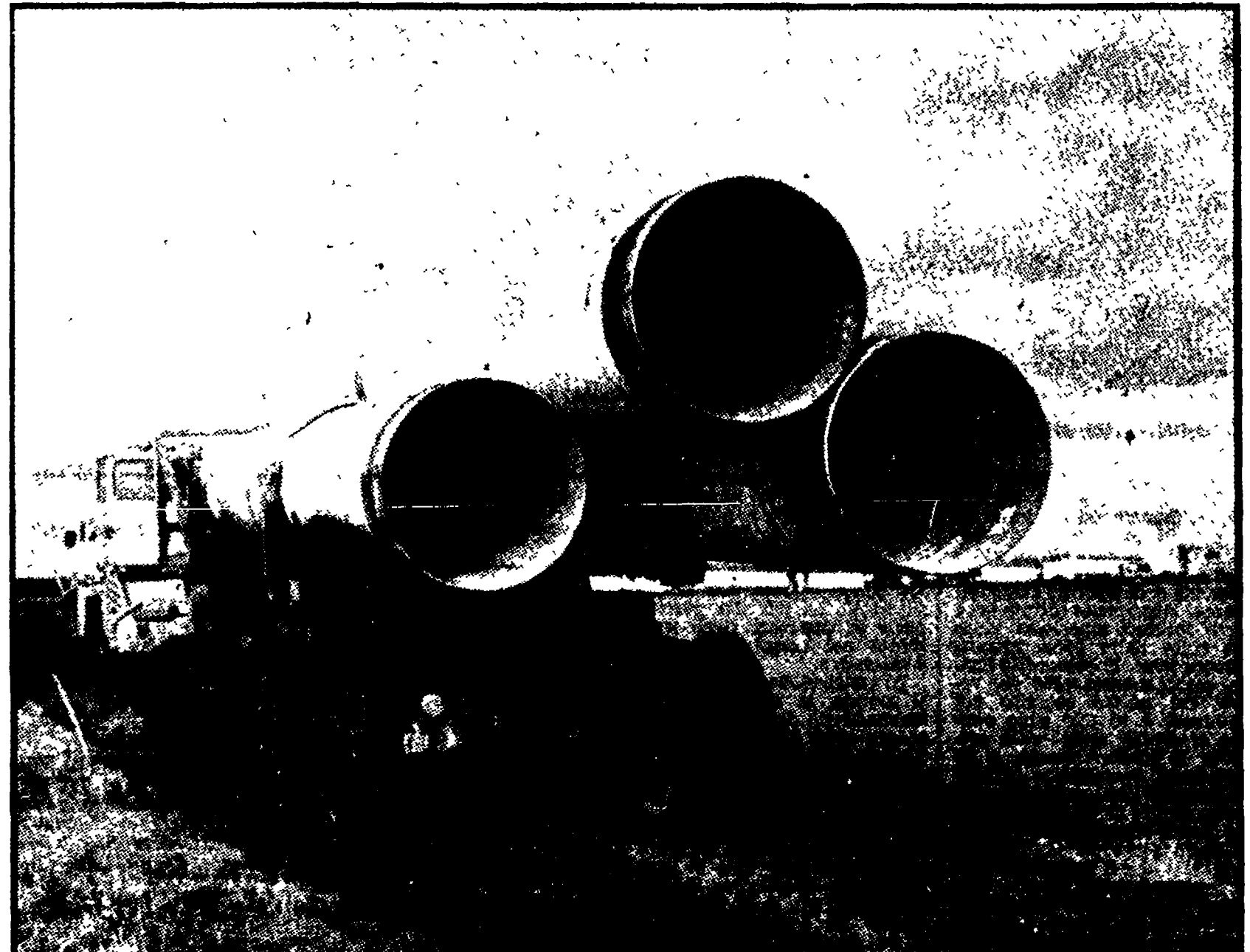
VELKE KOSTOLANY (Slovacchia orientale) - Metro dopo metro nasce il grande gasdotto di transito che dall'URSS, attraverso la Cecoslovacchia, raggiungerà l'Austria, l'Italia ed i due Stati tedeschi. Nella foto: le enormi sezioni di tubatura vengono avviate ai luoghi di posa.
