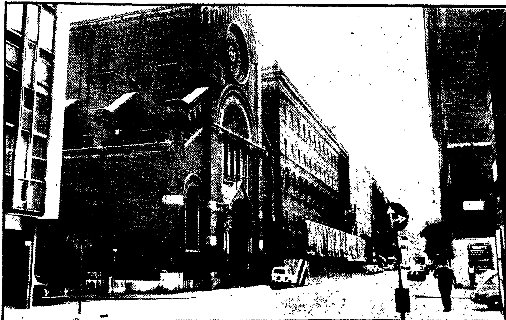
La facciata esterna della chiesa e dell'adiacente convento dove si sta compiendo lo scempio
