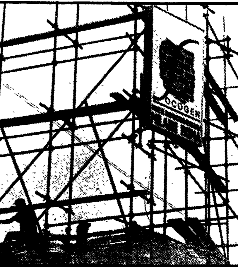
Una immagine del cantiere nell'ex convento dei cappuccini
