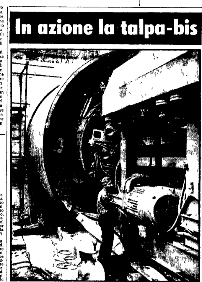
La « talpa », la grossa macchina che scava sotteranea le gallerie, si è rimessa in moto per i lavori della metropolitana a Roma...
