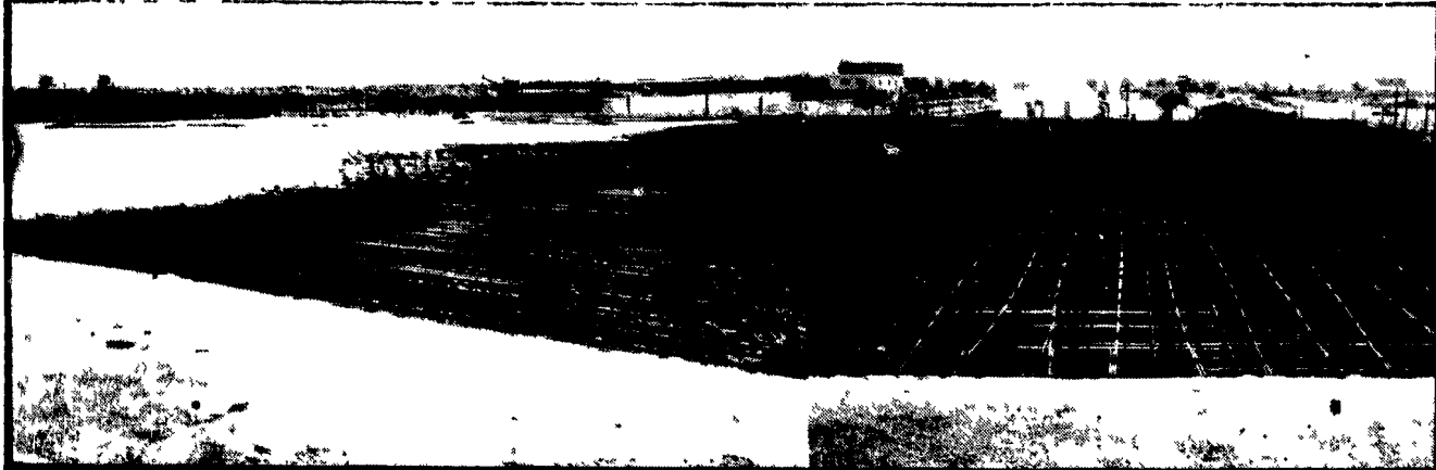
La seconda pista di Fiumicino in costruzione, gli operai sono costretti a vegliare anche di notte
