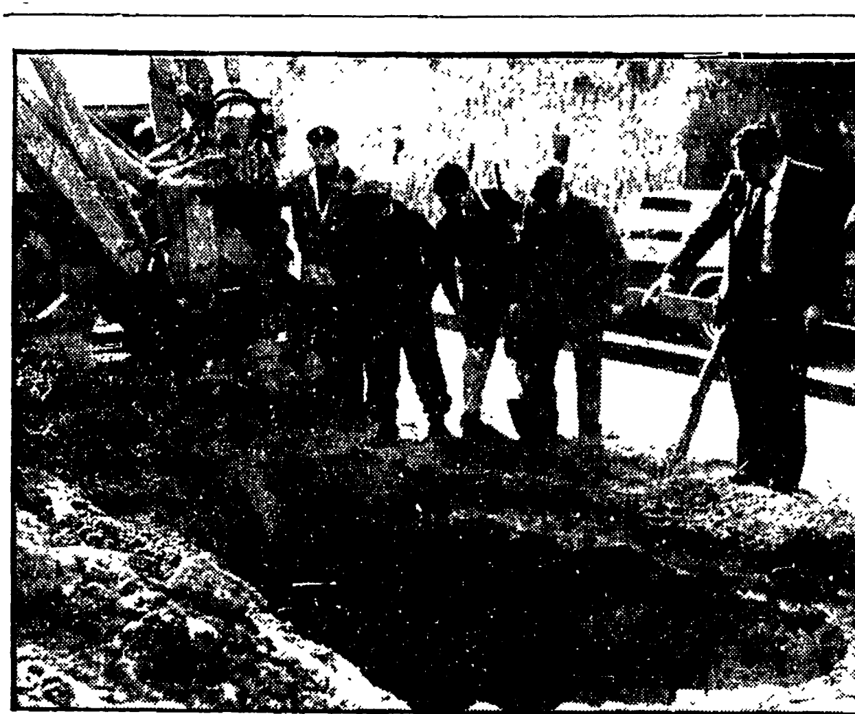
NAPOLI: PERICOLO DI SMOTTAMENTO A Napoli, in via Mascagni, che è il prolungamento di via Riberia, la sera del 29 novembre scorso si verificò una improvvisa voragine. Era una scava senza acqua, ma ci si accorse che era una cosa seria. Ci si è trovati di fronte, cioè, ad un terrapieno profondo una quindicina di metri e completamente inibito « per mesi, un « fognolo » privato aveva perduto acqua, lasciando defluire nel sottosuolo. Per fortuna, il segno premonitore del 29 novembre è stato giustamente interpretato da alcuni vigili urbani: altrimenti si sarebbe avvertito di ampie proporzioni e dalle conseguenze assai gravi. NELLA FOTO: la voragine in via Mascagni a Napoli.
