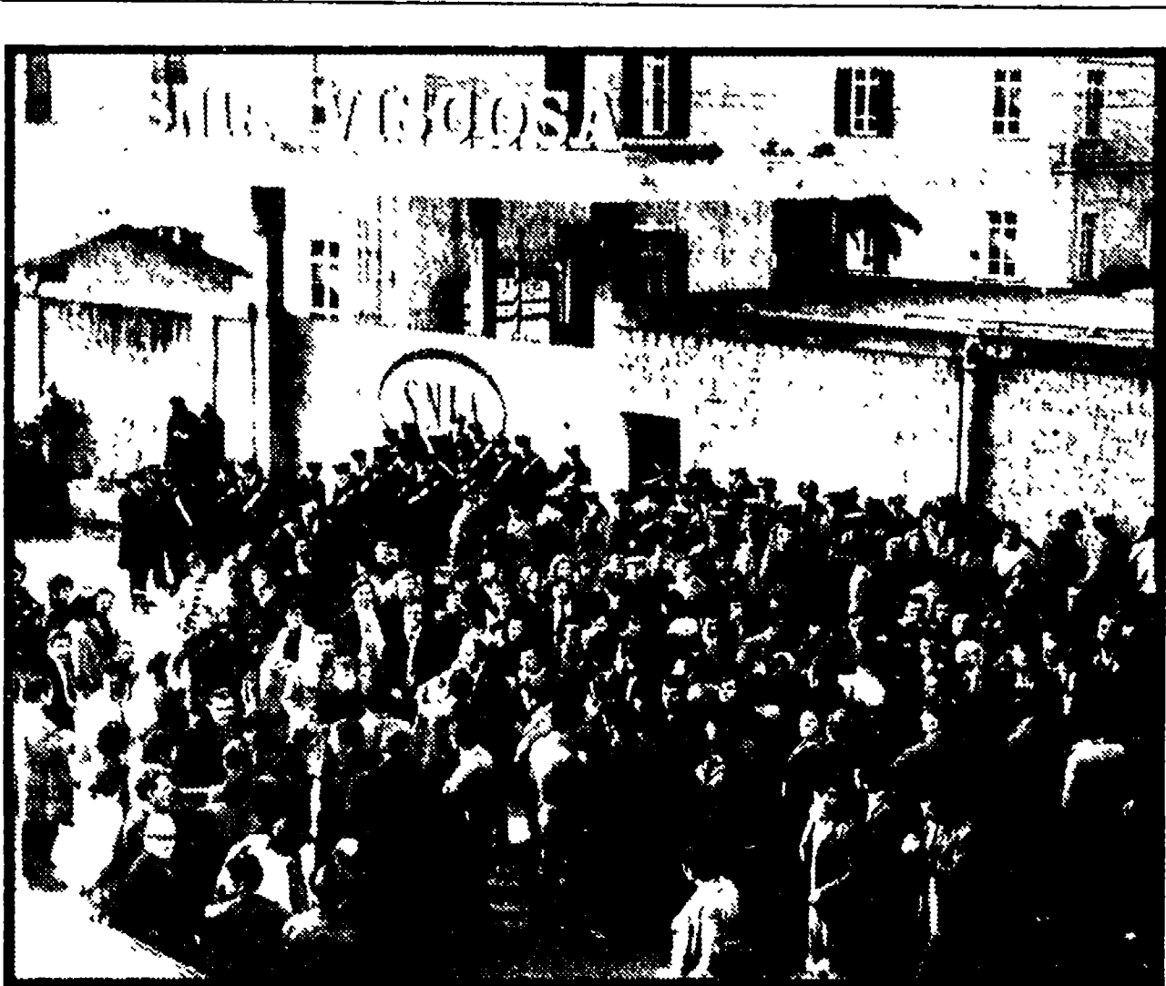
Operai della Snia davanti alla fabbrica, dopo le cariche della polizia
