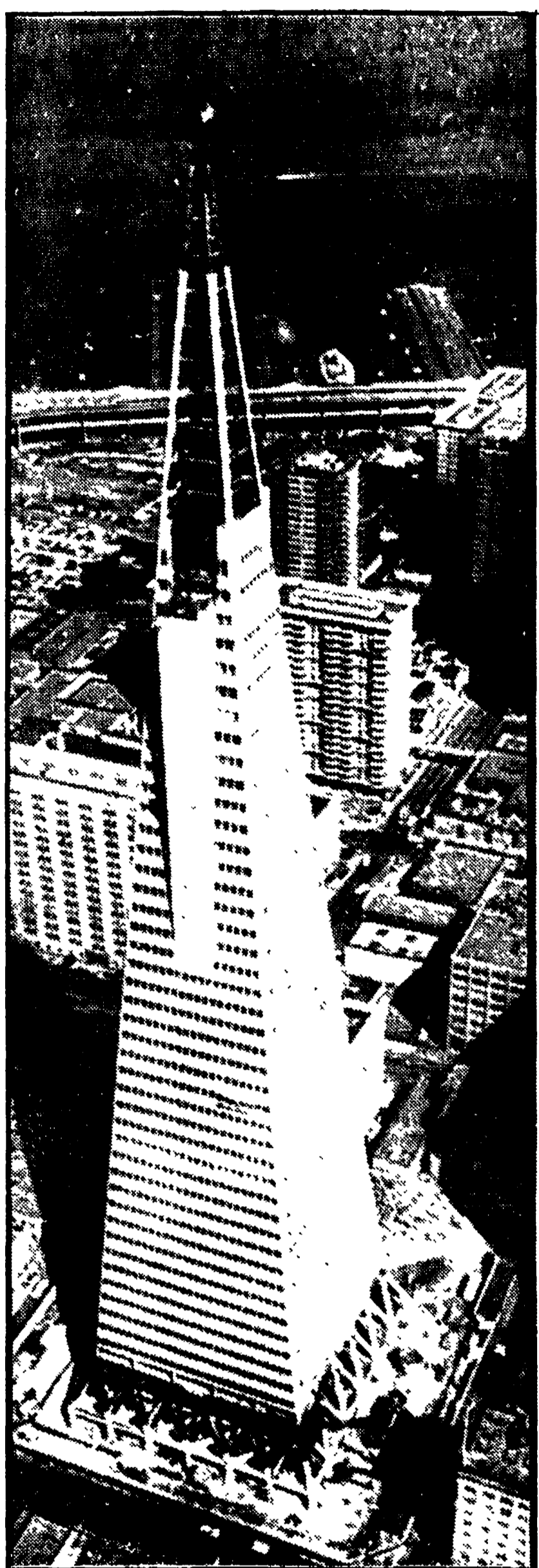
SAN FRANCISCO - La punta d'acciaio è stata appena collocata in cima all'edificio per essere pronto all'uso attende soltanto i pannelli esterni prefabbricati: il grattacielo a piramide è il nuovo "monumento" innalzato nel centro degli affari della città.
