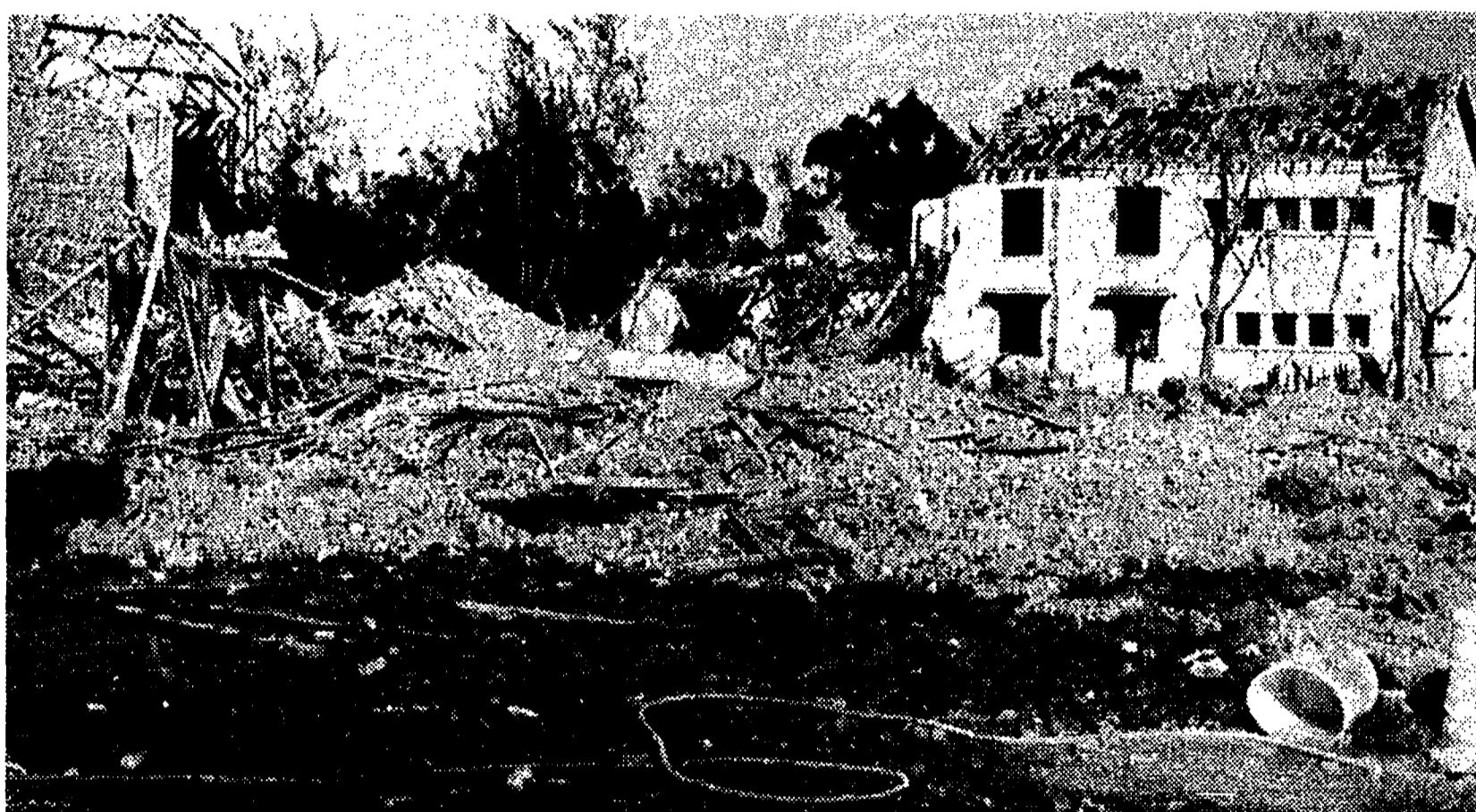
NORD VIETNAM - L'ospedale provinciale di Thanh Hoa, 130 km. a sud di Hanoi, distrutto dai bombardamenti americani.
