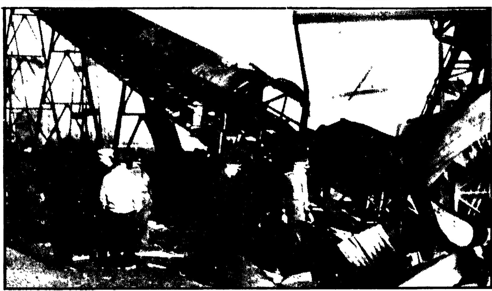
BRISBANE - Come si presenta l'ingresso della miniera dopo l'impiego del bulldozer
