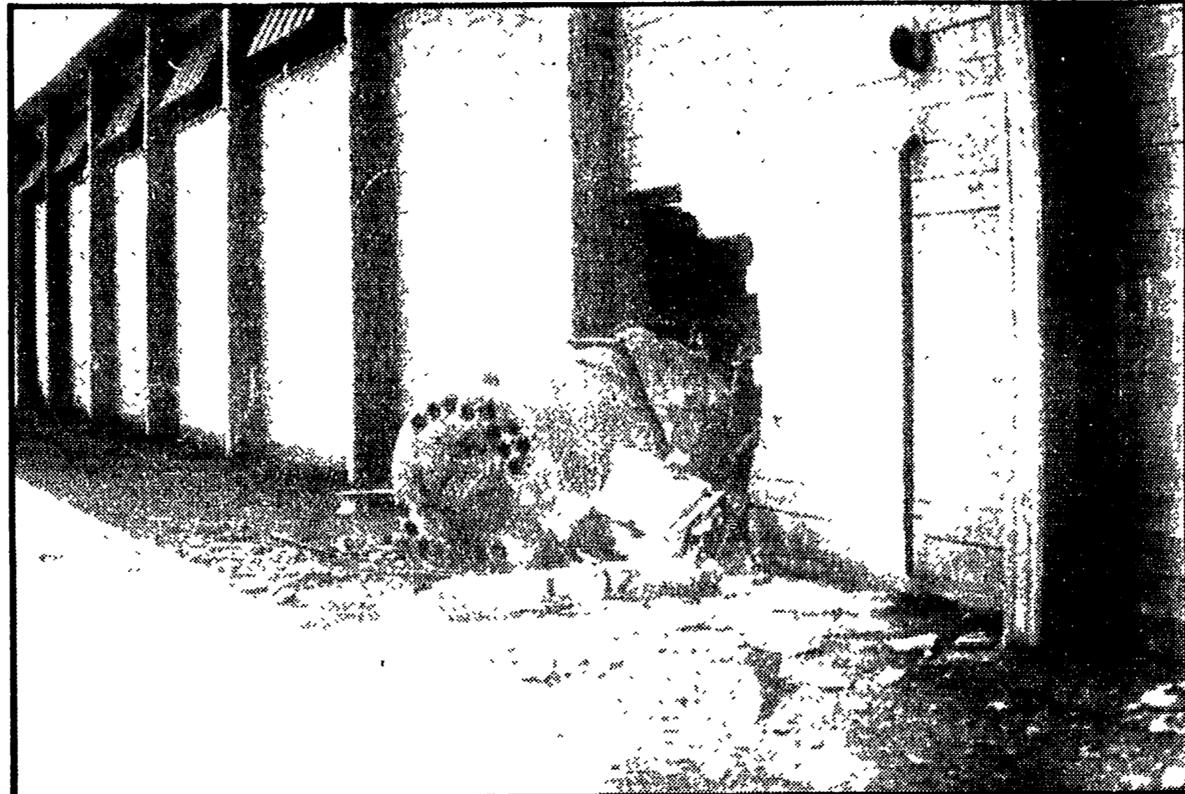
L'officina dove è avvenuta l'esplosione; la caldaia ha sfondato una parete
