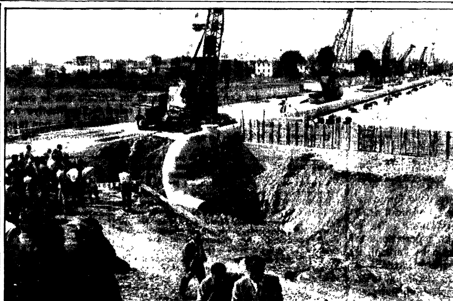
ACQUA PER MEZZO SECOLO BOLOGNA - Ci sono volute sei potenti autogrù per sollevare questo enorme tubo lungo 150 metri, largo un metro e venti e del peso di ben 120 tonnellate...
