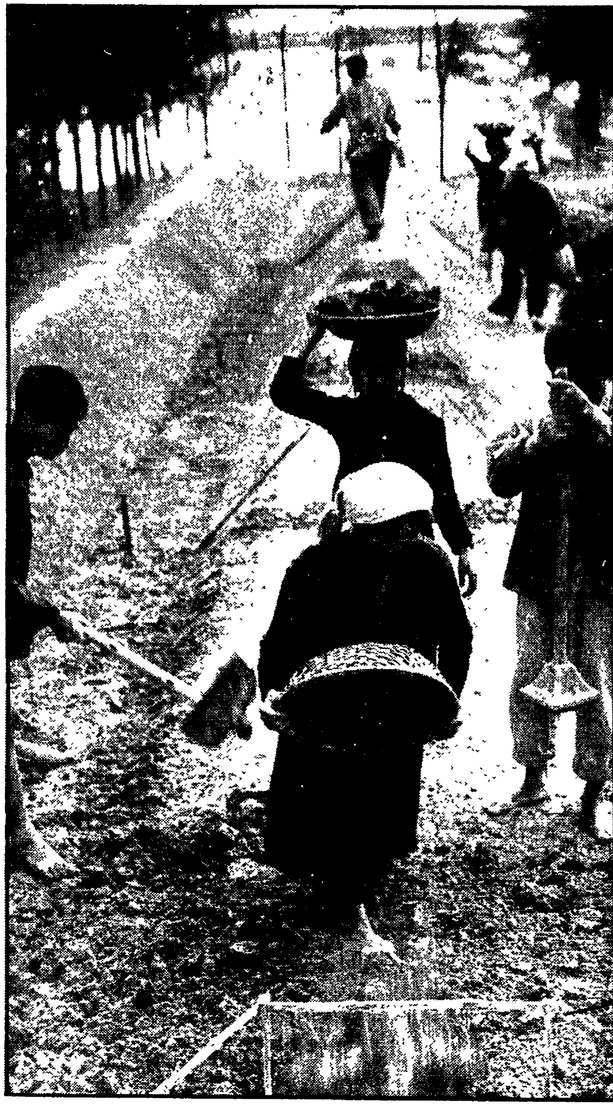
Una squadra di vietnamiti al lavoro per riparare i danni della « craterizzazione » americana
